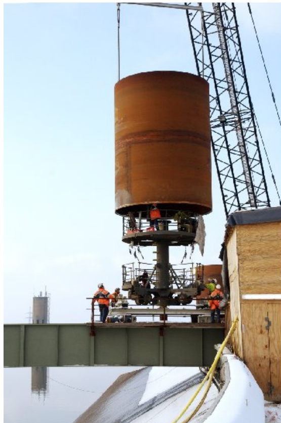
Abbildung 13: Einbau der Druckschachtpanzerung (Foto: SEO).
