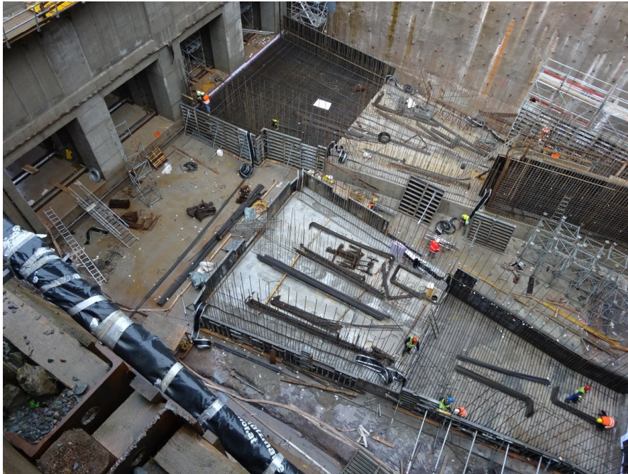
Abbildung 11: Aufteilung des Volumenstroms auf vier Rechenfelder im Unterbecken (Foto: SEO).
