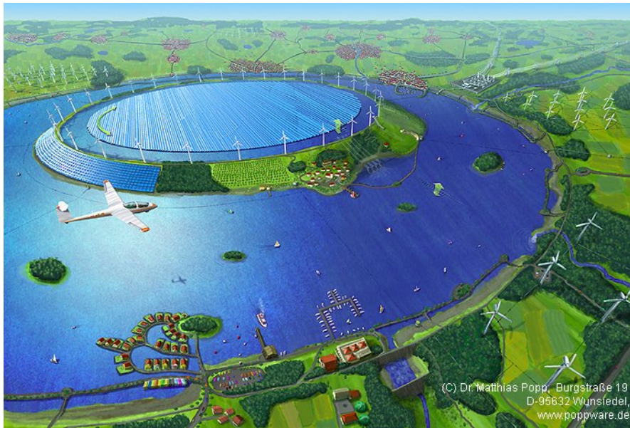
Abbildung 24: Idee eines riesigen Flachland-Pumpspeicherkraftwerks (Bild: Stefan Schiessl / Mathias Popp).
