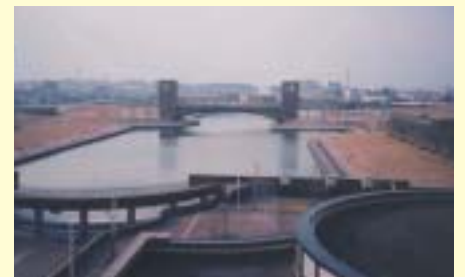
美しい公園「富岩（ふがん）運河環水公園」が隣接する富山県民共生センター
