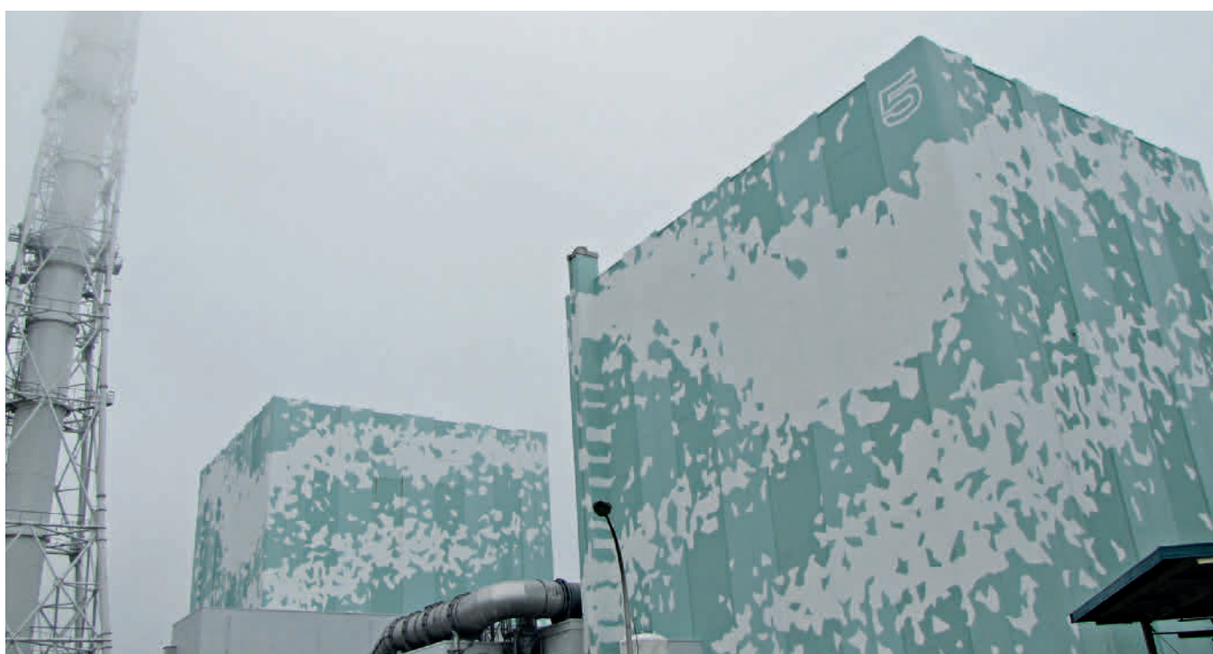
Abb. 3.33: Die nicht zerstörten Blöcke 5 und 6 im September 2011 (Quelle: TEPCO).
