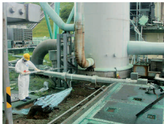
Abb. 5.6: Messung der Ortsdosisleistung mit einem Teleskopdetektor am Abluftkamin der Blöcke 1 und 2 (Quelle: TEPCO).
