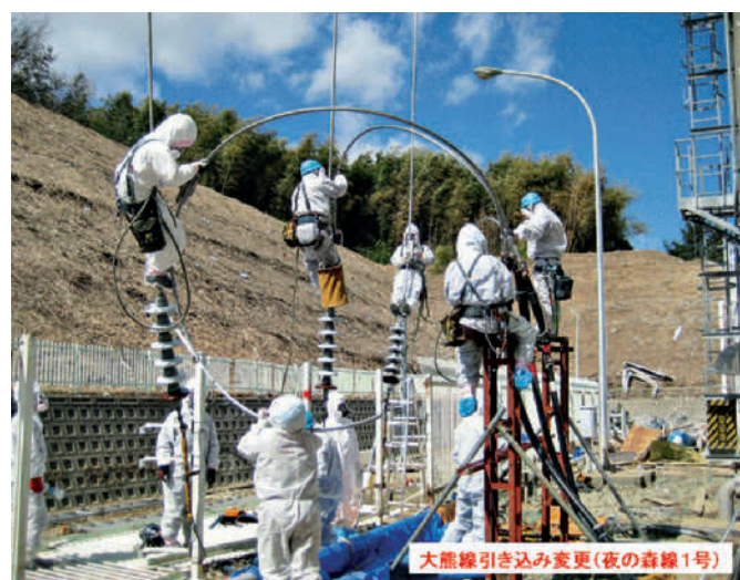
Abb. 6.5: Arbeiten zur Wiederherstellung der Anbindung der Anlage an das Stromnetz (Quelle: TEPCO).
