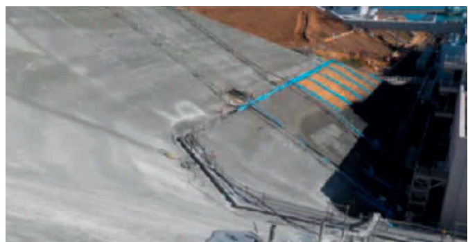
Abb. 6.18: Beispiel für die Flächenversiegelung auf dem Anlagengelände; oben nach der Rodung, unten nach der Versiegelung (Quelle: TEPCO).
