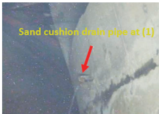
Abb. 6.31: Foto des eingesetzten Bootes zur Inspektion des Torusraums (links) und Foto einer Leckagestelle (rechts) (Quelle: TEPCO).
