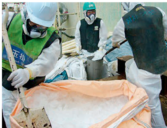
Abb. 6.17: Einbringen von Eis in einen Schacht des Rohrleitungstunnels im Maschinenraum von Block 2 (Quelle: TEPCO).
