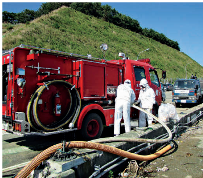
Abb. 3.22: Einspeisung von Seewasser in das Feuerwehrfahrzeug (Quelle: TEPCO).
