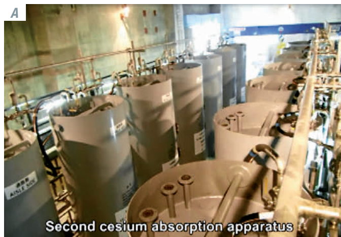
Abb. 6.8 A+B: Blick in die Wasseraufbereitungsanlage (Quelle: TEPCO).
