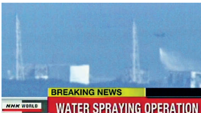
Abb. 3.26: Wasserabwurf aus einem Hubschrauber über den zerstörten Blöcken (Quelle: NHK).
