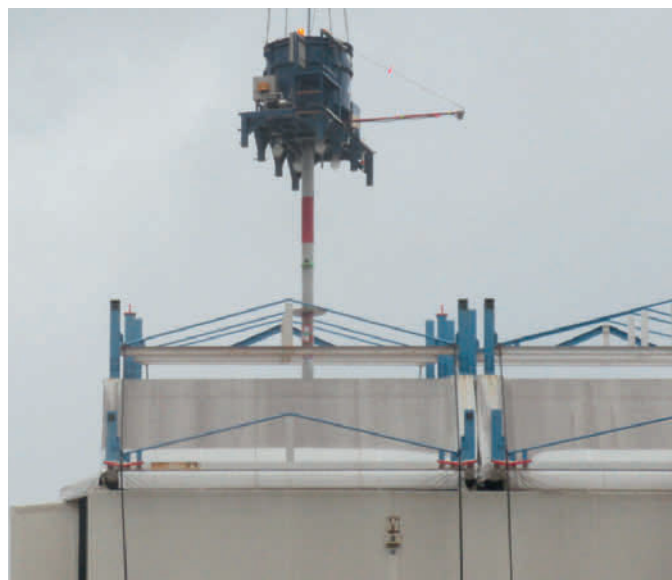
Abb. 6.21: Bohrungen in den Deckenelementen (Quelle: TEPCO).
