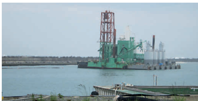
Abb. 6.19: Schwimmendes Arbeitsgerät zur Versiegelung des Meeresbodens (Quelle: TEPCO).
