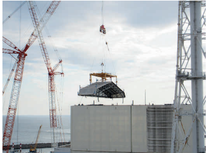
Abb. 6.22: Abheben des letzten Deckenelements von Block 1 (Quelle: TEPCO).
