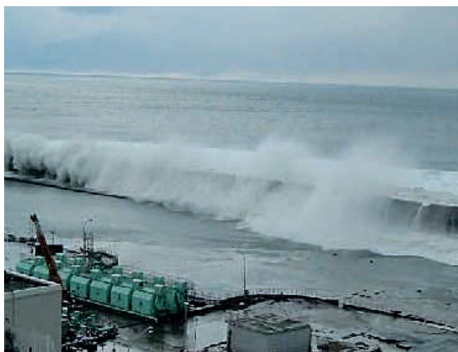
Abb. 3.12: Überflutung des seeseitigen Teils des Anlagengeländes durch erste Tsunamiwellen, aufgenommen durch eine Überwachungskamera (Quelle: TEPCO).
