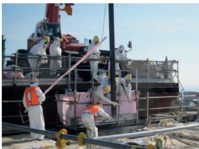
Abb. 6.25: Probeweise Bergung eines unbestrahlten Brennelements aus dem BE-Lagerbecken von Block 4 im Juli 2012 (Quelle: TEPCO).
