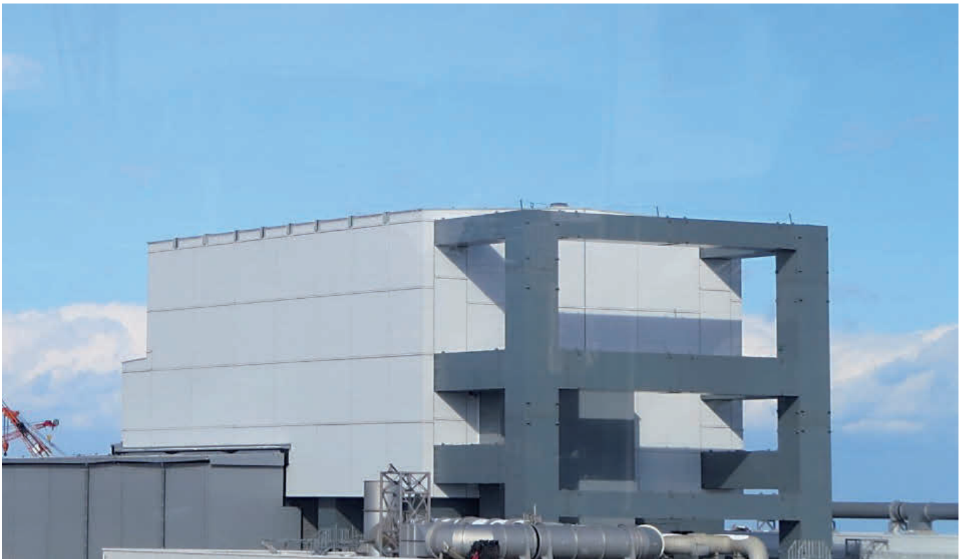
Abb. 6.24: Block 4 nach der Einhausung (Quelle: TEPCO).
