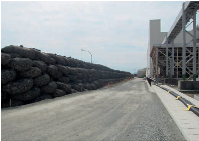
Abb. 6.2: Schutzwall gegen Tsunamis (Quelle: TEPCO).
