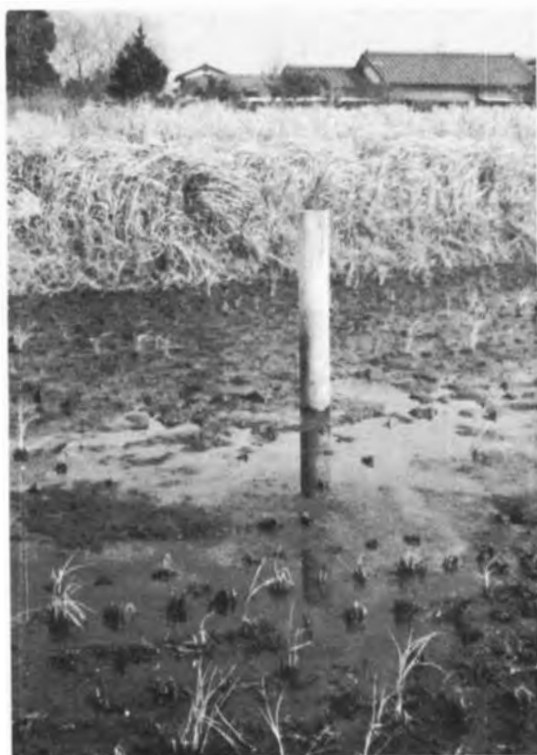
第87図 市原市海士有木付近の自噴井 あまありき 養老川沖積低地には上総掘りによる自噴井が多数分布していたが、昭和35年頃から東京湾岸で自噴停止が始まり、この付近も昭和40年代に停止した。その後地下水位の回復に伴い、ここでは昭和55年頃から再び自噴が始まった
