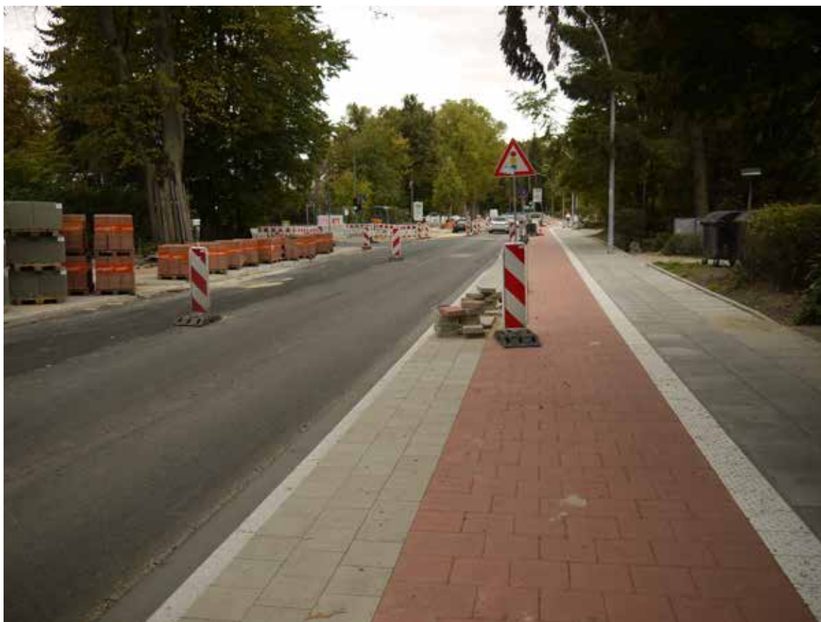
Bild 154: Meiendorfer Straße, Neubau der Radwege
