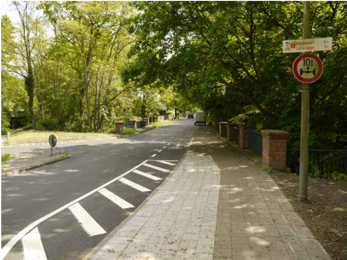
Bild 49: Am Langberg (Veloroute 8), Ableitung in den Mischverkehr
