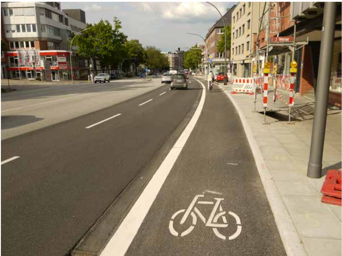
Bild 126: Lübecker Straße, Radfahrstreifen
