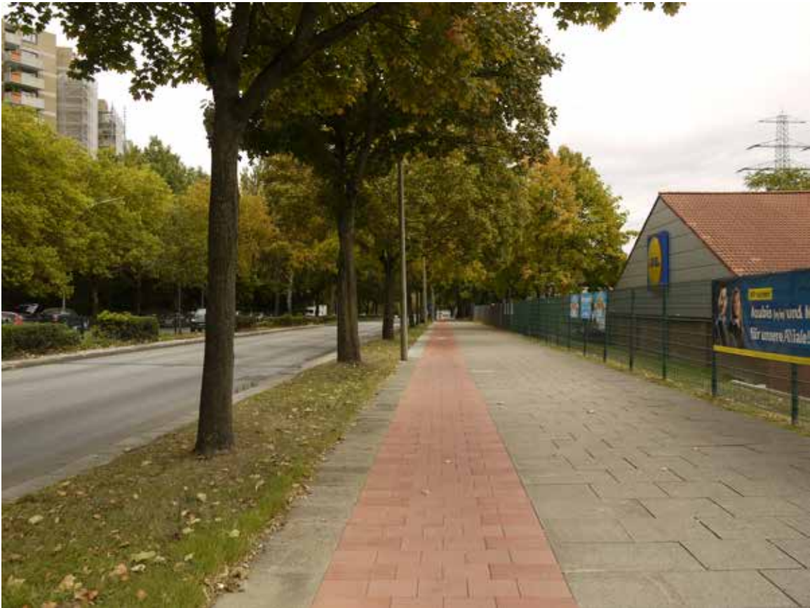
Bild 31: Steilshooper Allee (Veloroute 5), Instandsetzung Radweg
