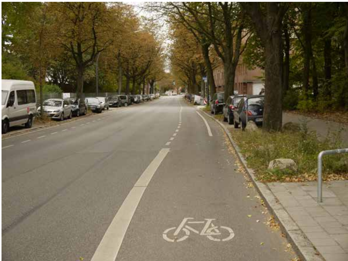
Bild 28: Rümkerstraße (Veloroute 5), Radfahr-/Schutzstreifen
