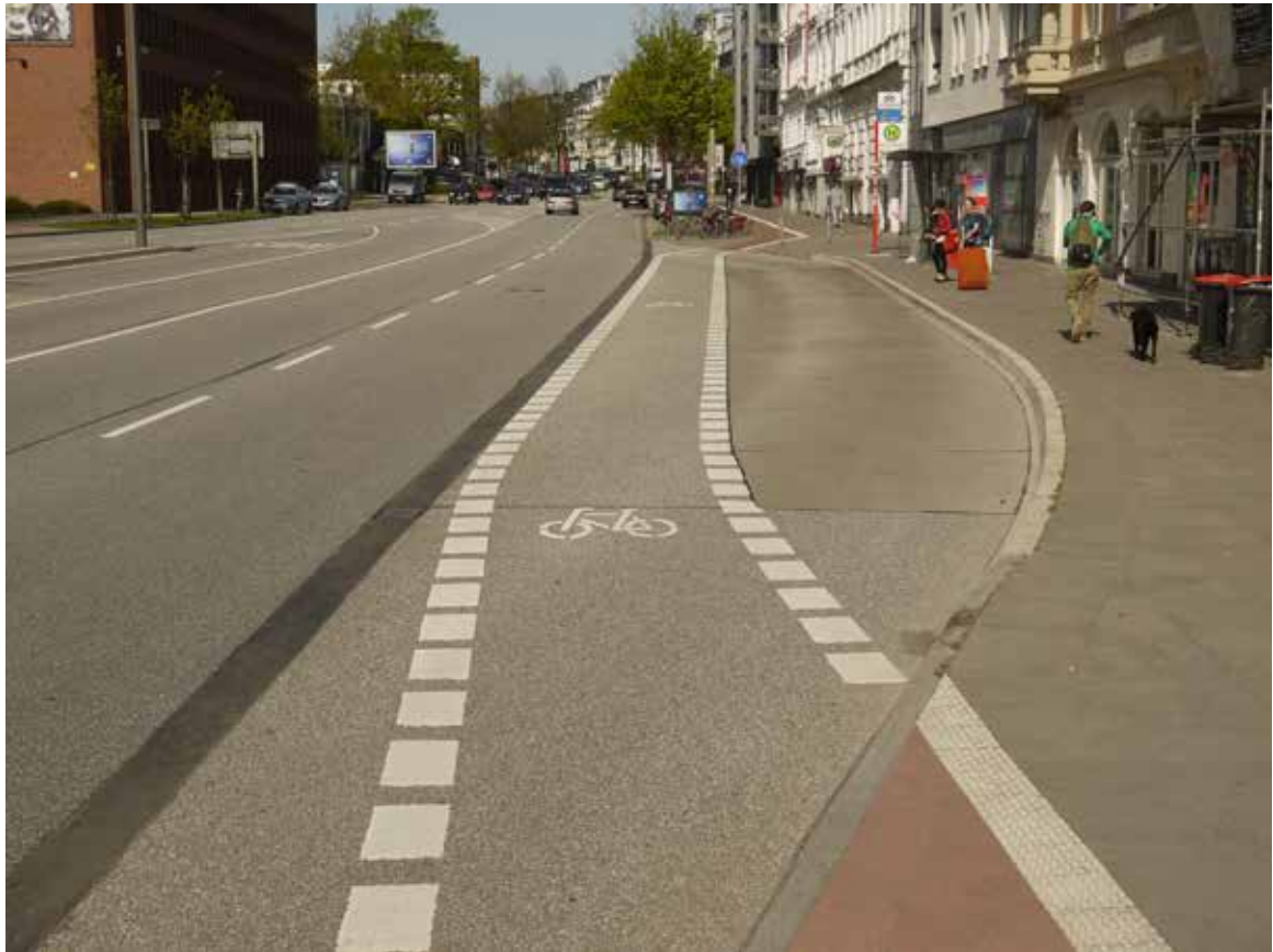
Bild 93: Stresemannstraße, Radfahrstreifen an Bushaltestelle
