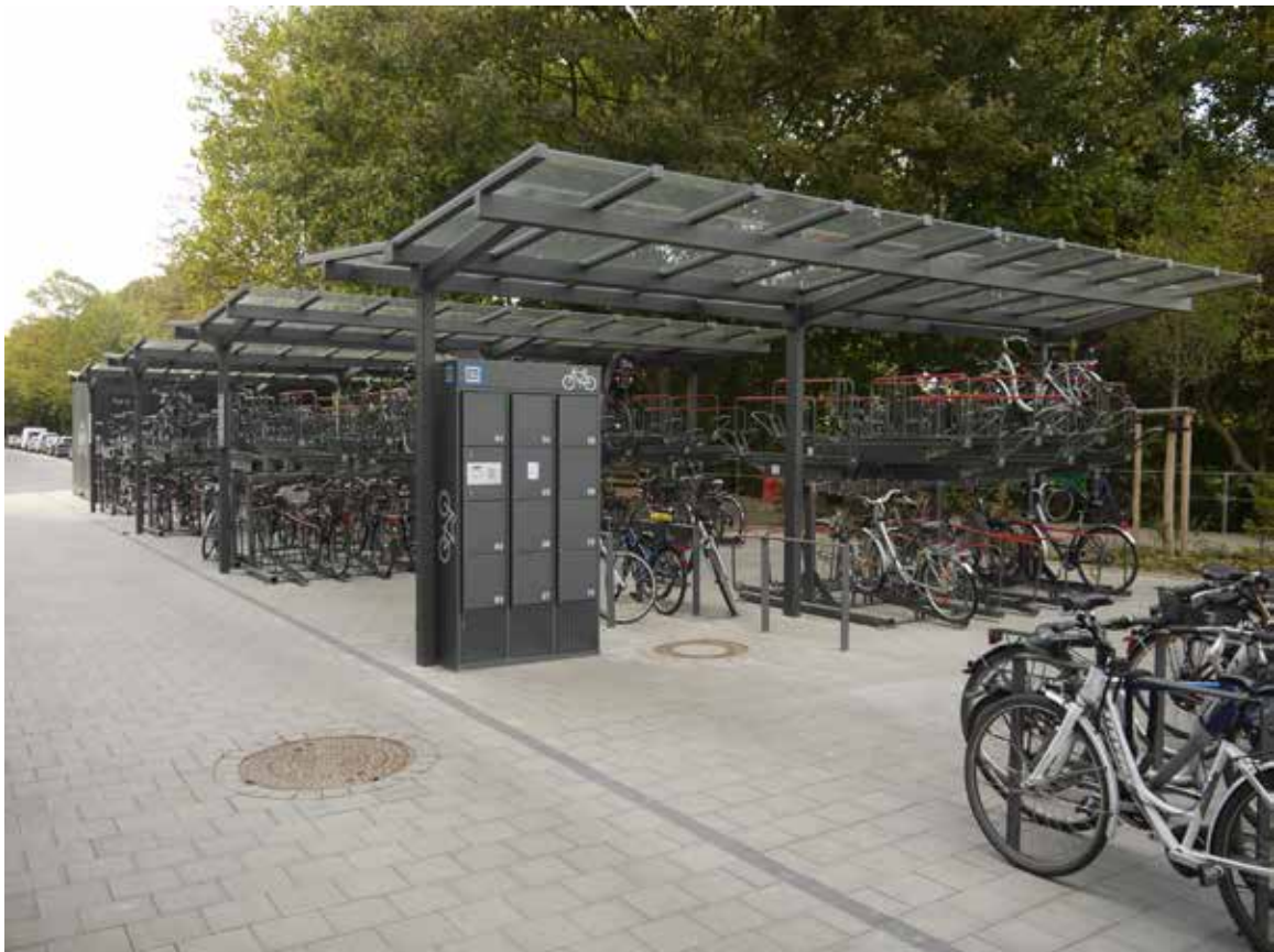
Bild 182: Bike+Ride-Anlage U-Bahn-Haltestelle Hoheluftbrücke, überdachte Doppelstockparker und Schließfächer
