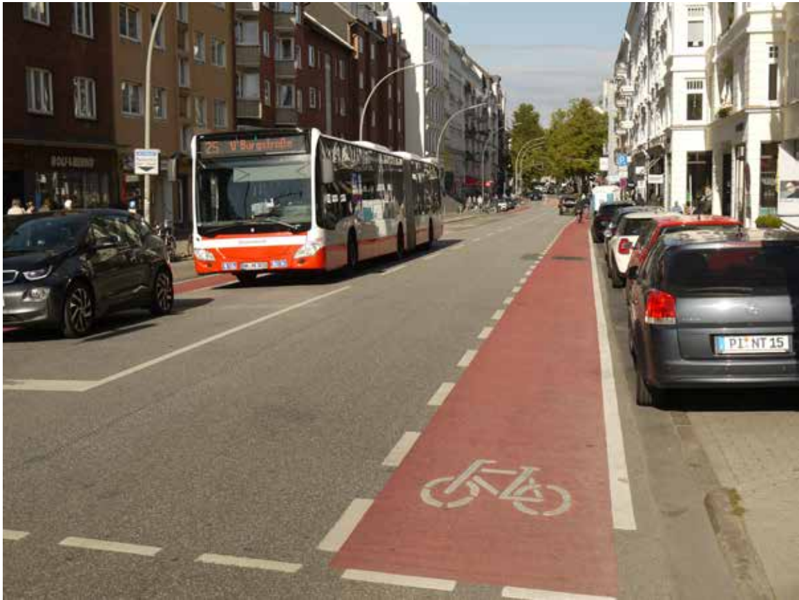
Bild 135: Mühlenkamp, Schutzstreifen mit Roteinfärbung
