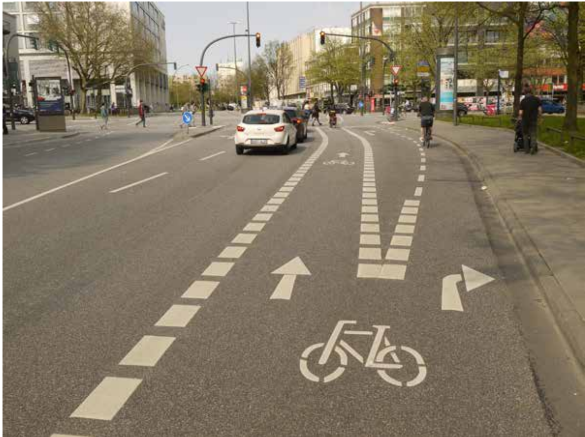
Bild 89: Pepermölenbek / Reeperbahn / Holstenstraße / Königstraße, Radfahrstreifen
