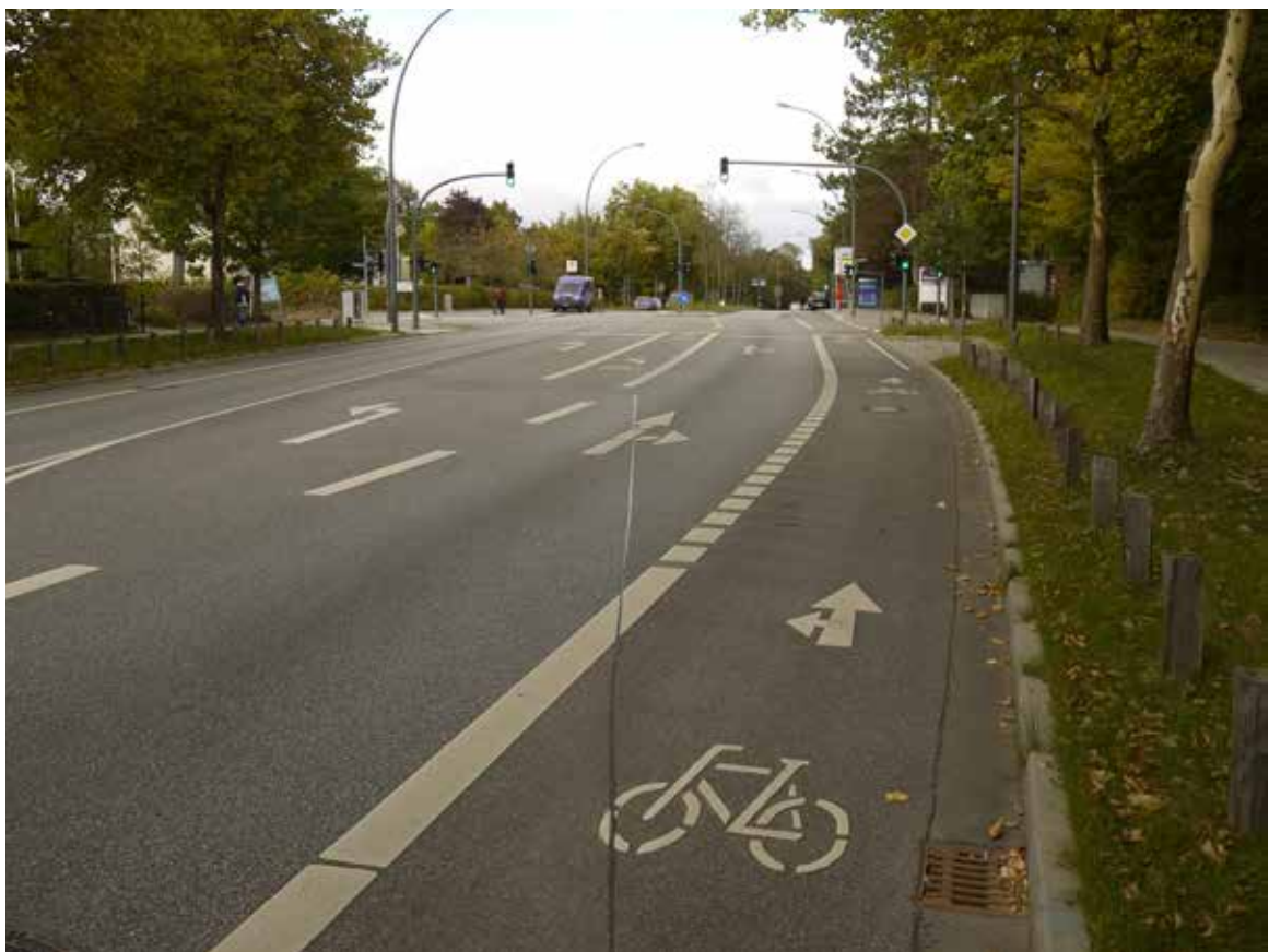
Bild 150: Alte Landstraße / Hinsbleek, Radfahrstreifen
