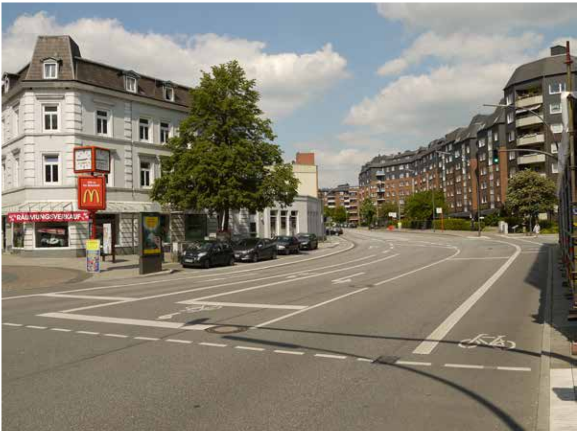
Bild 52: Ludwig-Rosenberg-Ring (Veloroute 8), Radfahrstreifen und aufgeweiteter Radaufstellstreifen (ARAS)
