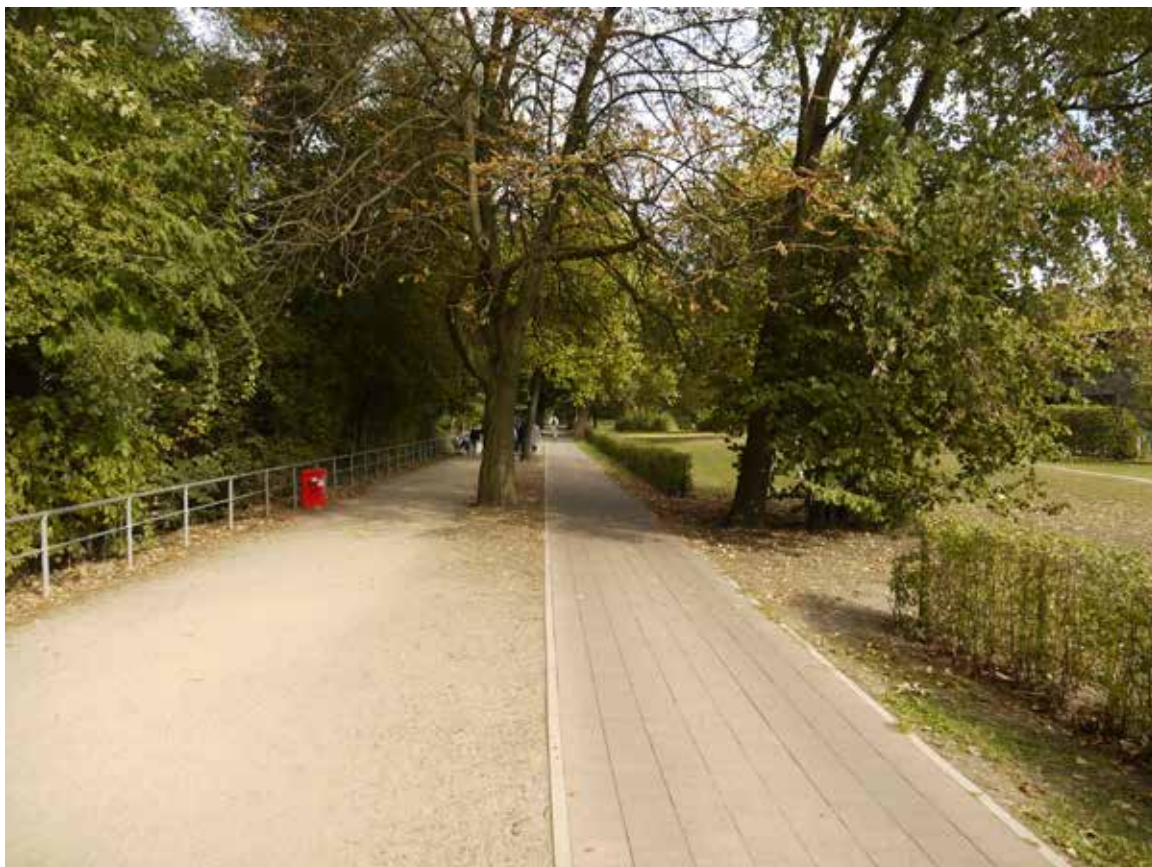
Bild 117: Kaiser-Friedrich-Ufer, Instandsetzung des Radwegs
