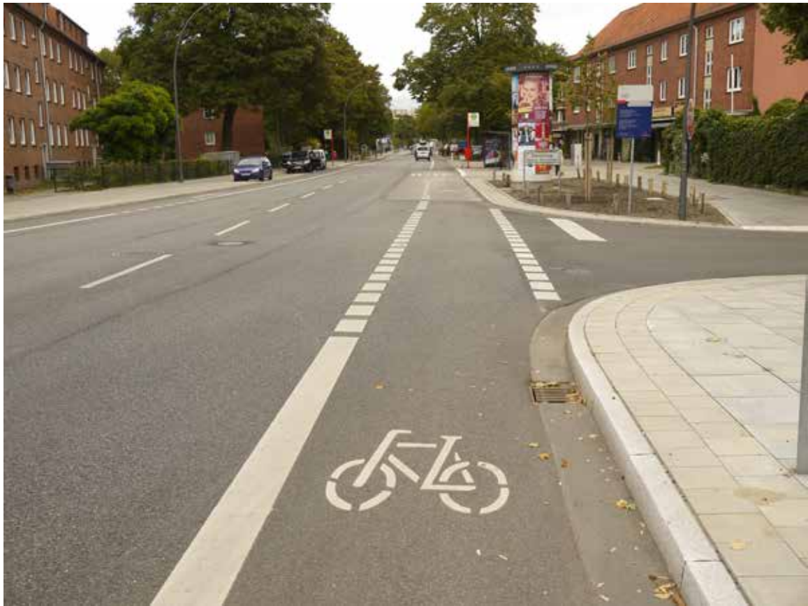
Bild 29: Steilshooper Straße (Veloroute 5), Radfahrstreifen
