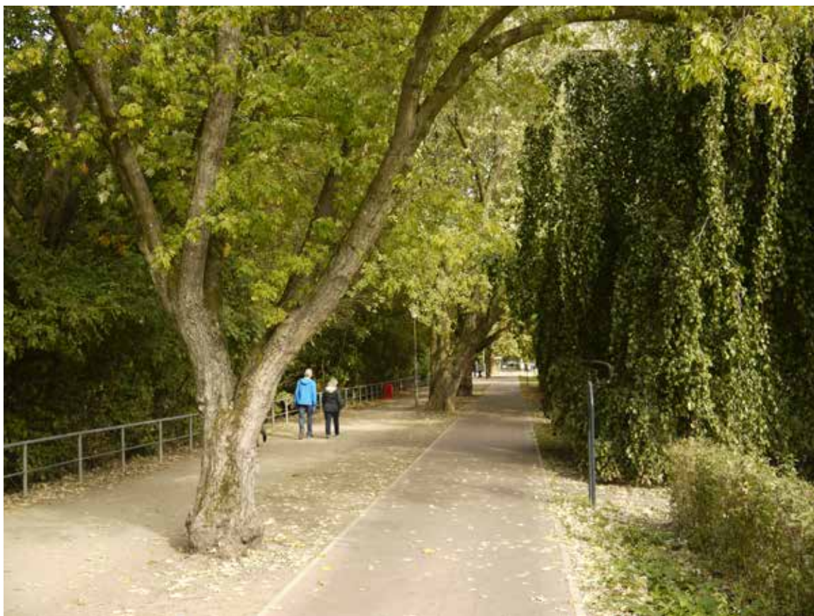
Bild 118: Kaiser-Friedrich-Ufer, Instandsetzung des Radwegs
