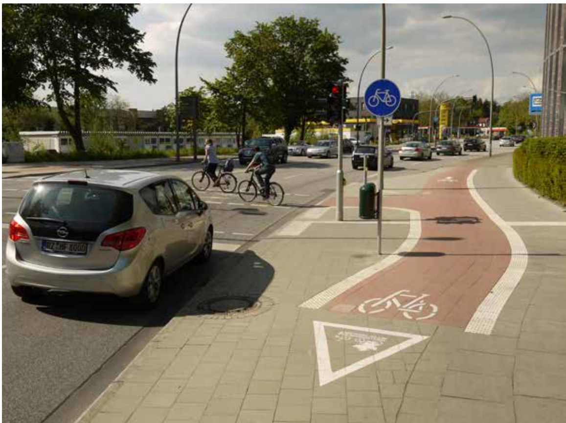
Bild 56: Kurt-A.-Körper-Chaussee (Veloroute 9) / Bergedorfer Straße, neue signalisierte Querung für Radverkehr und Piktogramm gegen Falschfahrer
