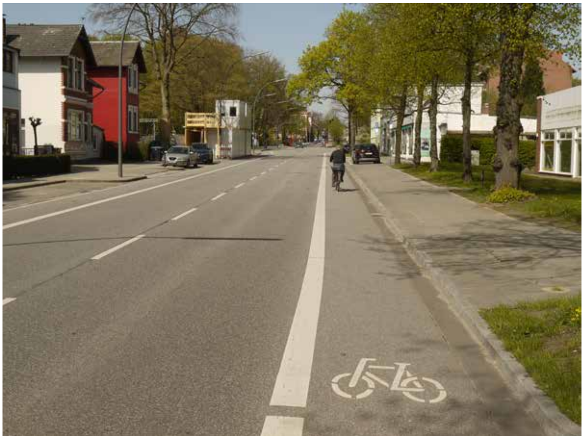
Bild 98: Bahrenfelder Chaussee, Radfahrstreifen
