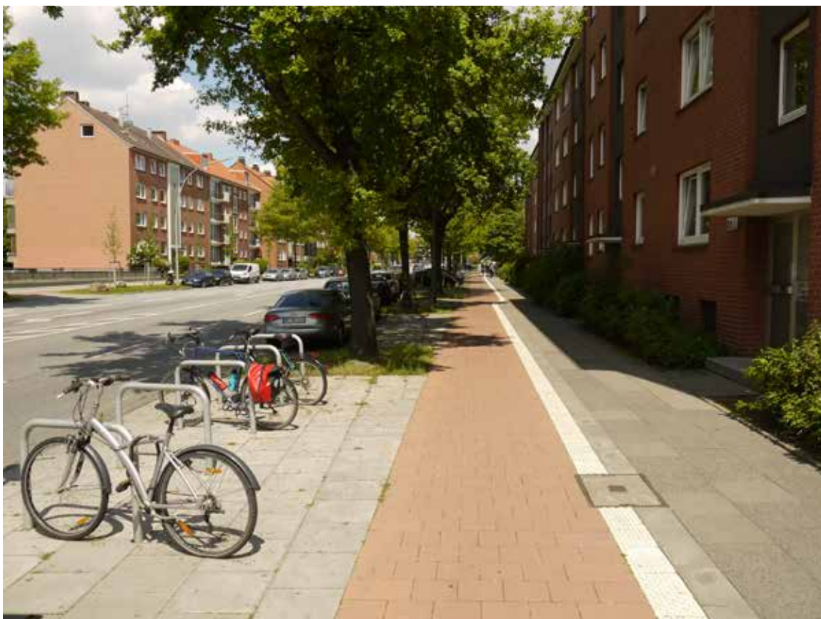
Bild 76: Grevenweg, Instandsetzung des Radwegs und neue Fahrradbügel
