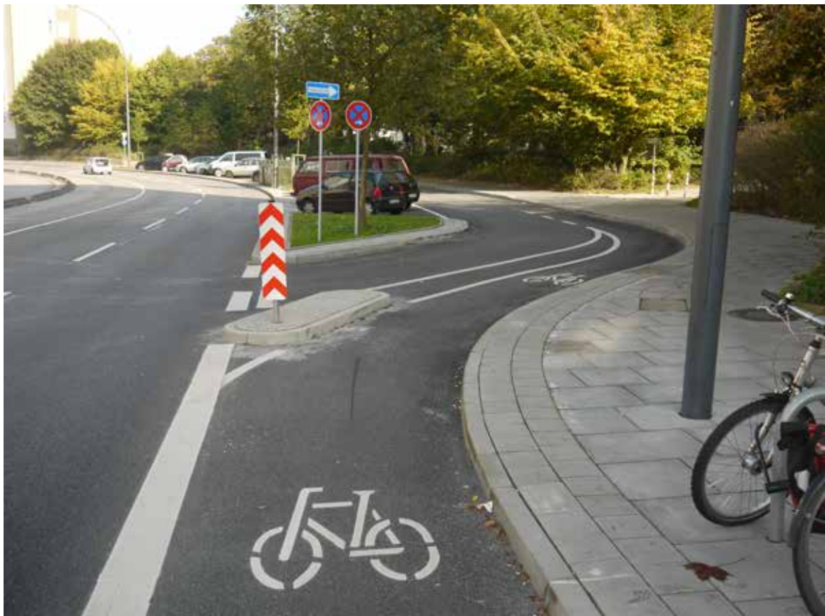
Bild 112: Grindelberg, Radverkehrsführung durch Nebenfahrbahn
