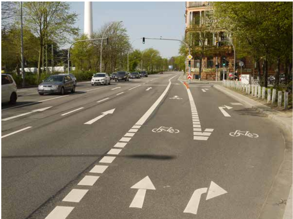
Bild 106: Bundesstraße / An der Verbindungsbahn, Radfahrstreifen
