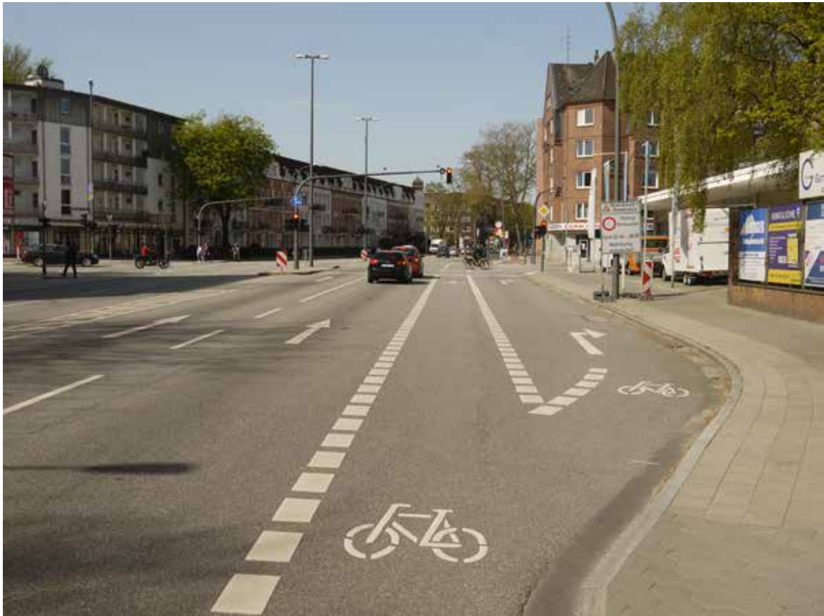
Bild 95: Stresemannstraße / Bornkampsweg / Bahrenfelder Chaussee / Bahrenfelder Steindamm, Radfahrstreifen
