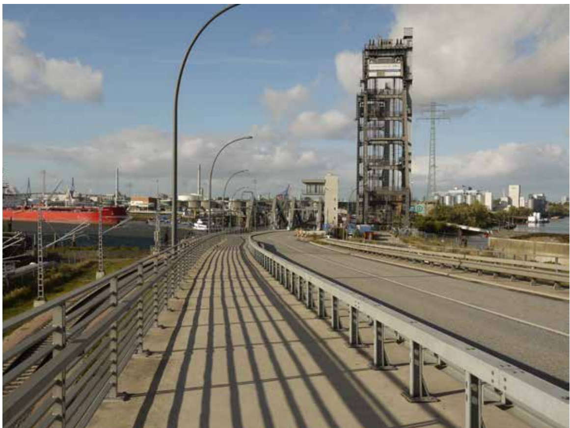
Bild 86: Rethedamm / Rethebrücke, gemeinsamer Geh- und Radweg
