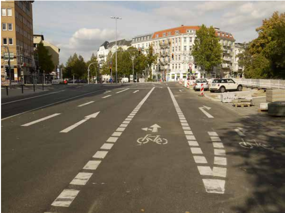
Bild 7: Schanzenstraße (Veloroute 2), Radfahrstreifen Richtung Weidenallee
