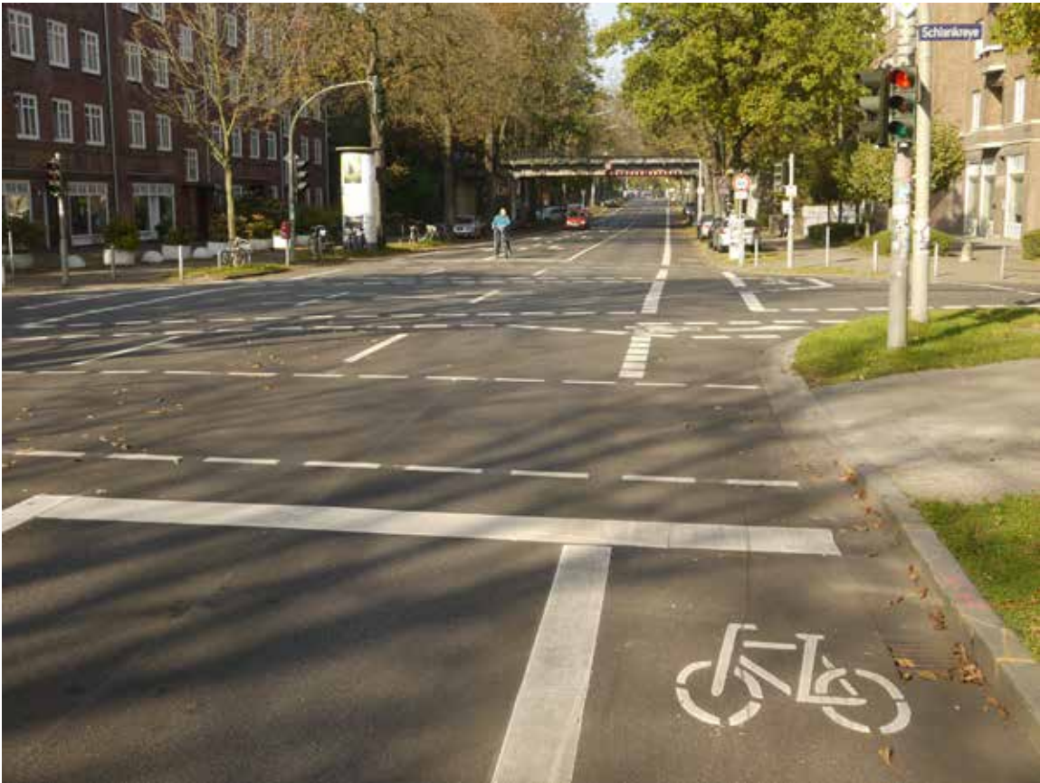
Bild 11: Bogenstraße (Veloroute 3), Instandsetzung der Fahrbahn einschl. der Radfahrstreifen
