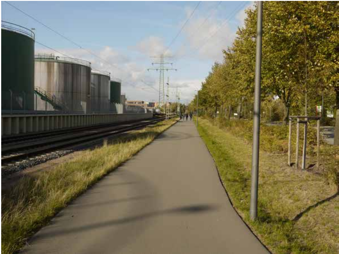
Bild 87: Rethedamm, selbstständig geführter Geh- und Radweg
