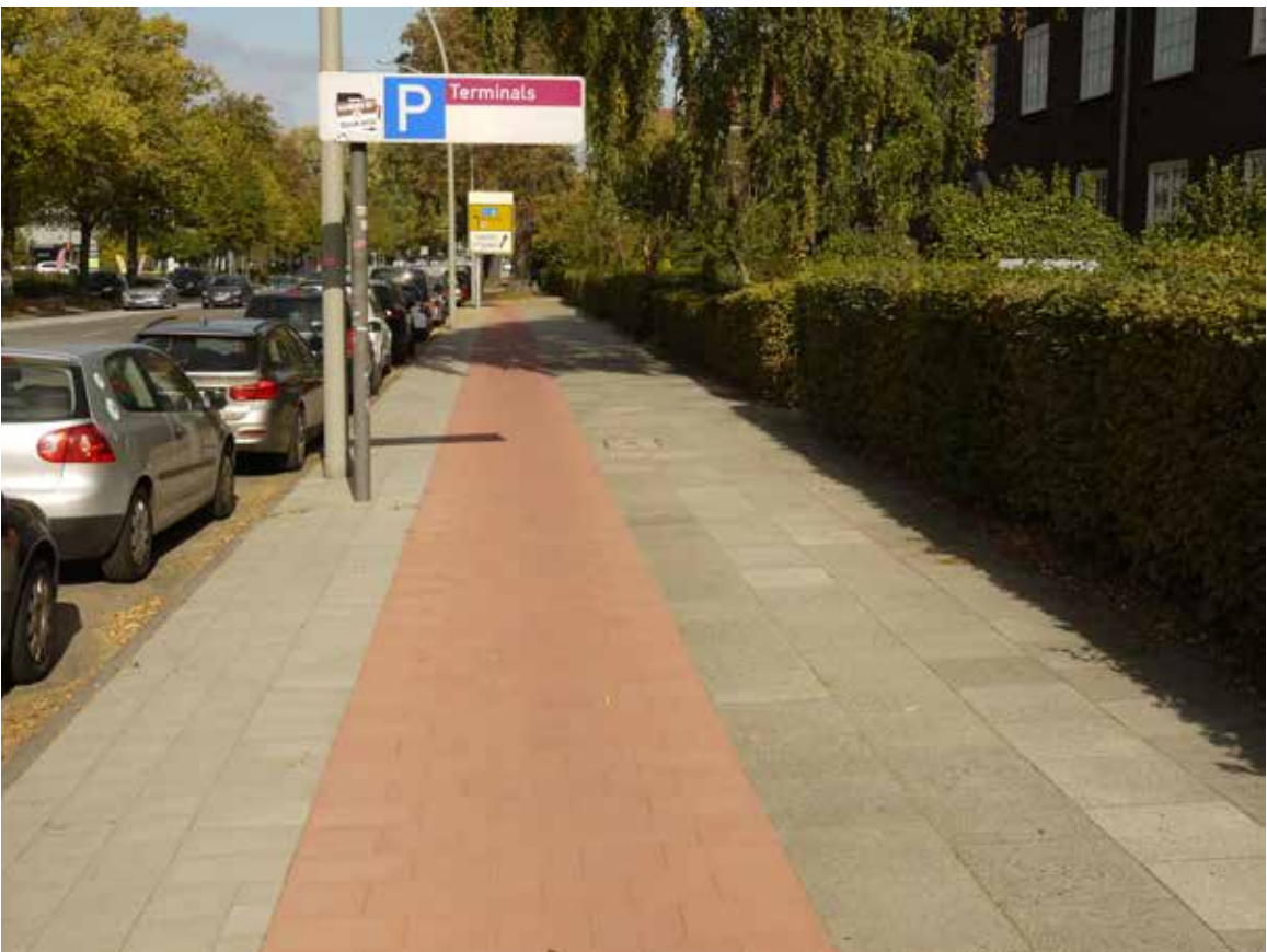
Bild 142: Alsterkrugchaussee, Instandsetzung der Radwege
