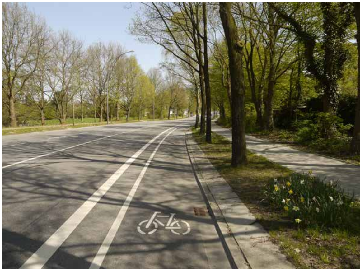
Bild 104: Rugenfeld, Radfahrstreifen mit doppeltem Trennstrich
