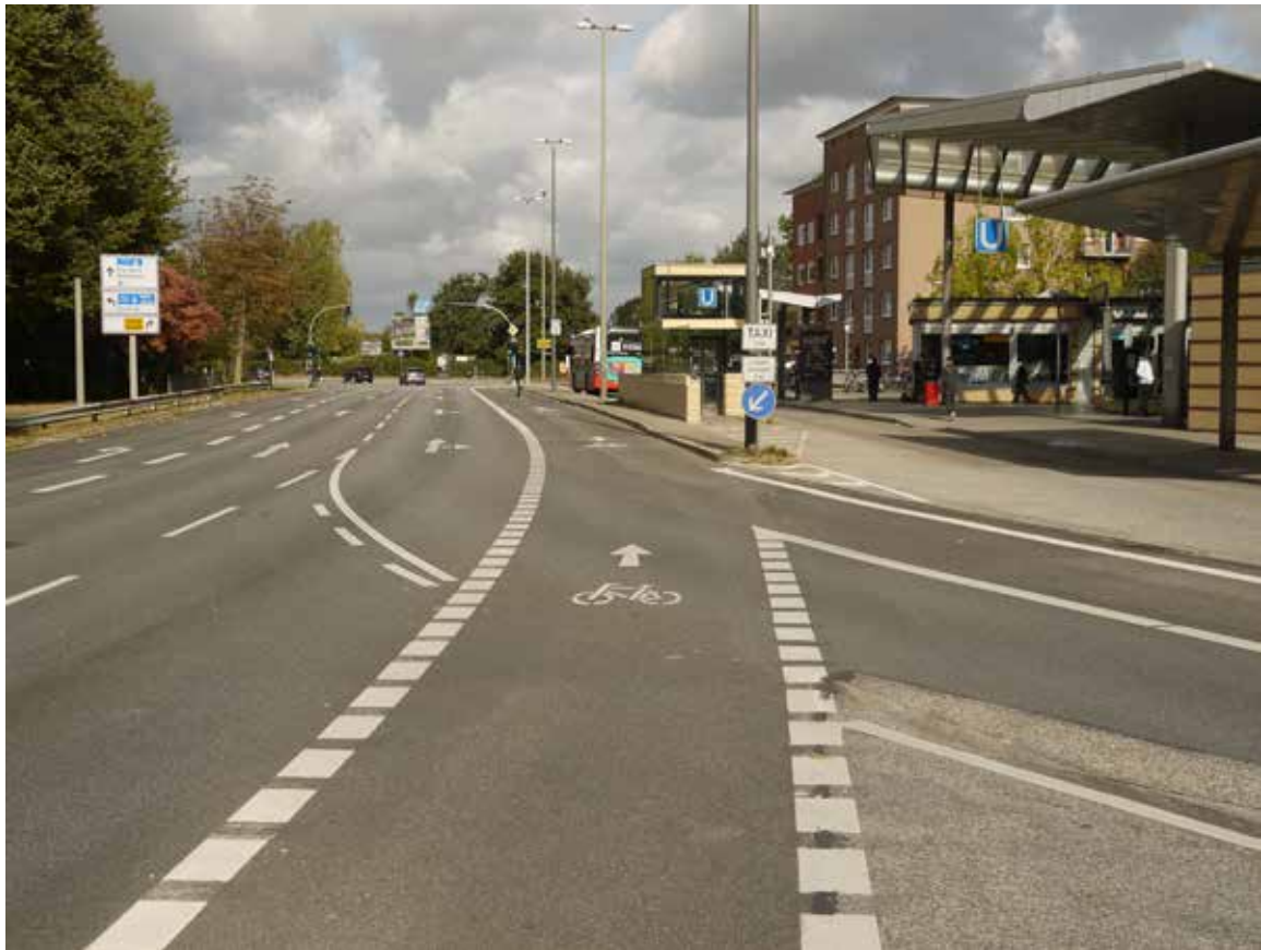
Bild 47: Rennbahnstraße (Veloroute 8), überbreiter Radfahrstreifen
