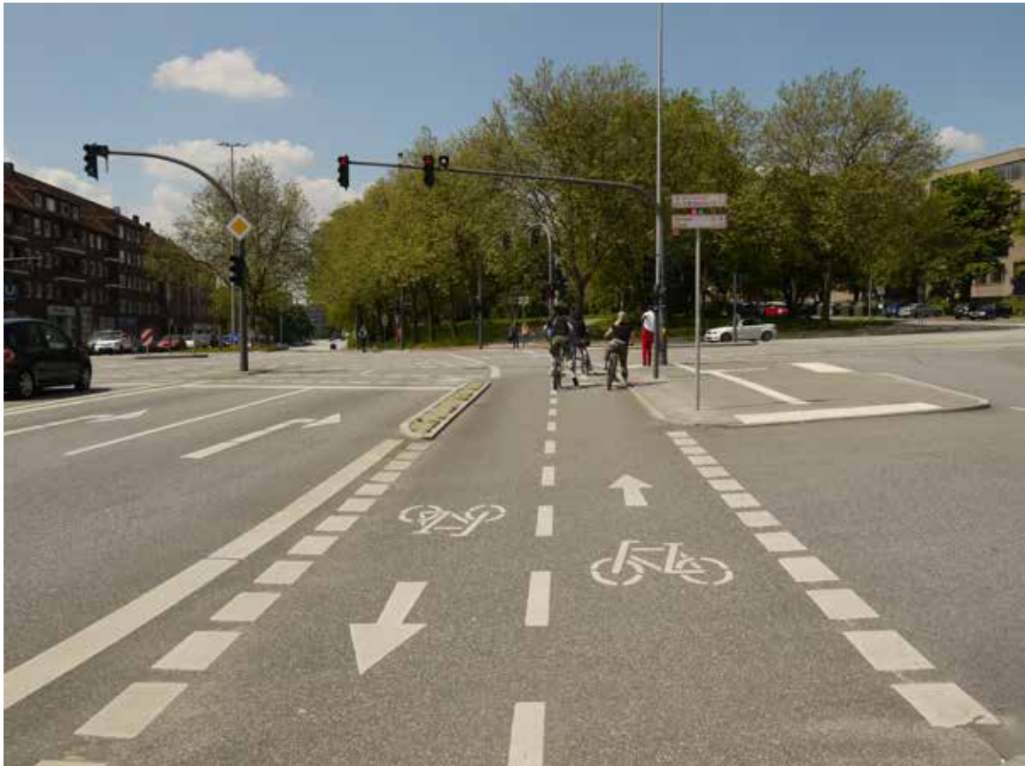
Bild 41: Hammer Landstraße (Veloroute 8), Zweirichtungsradweg zur Verbindung der Grünzüge
