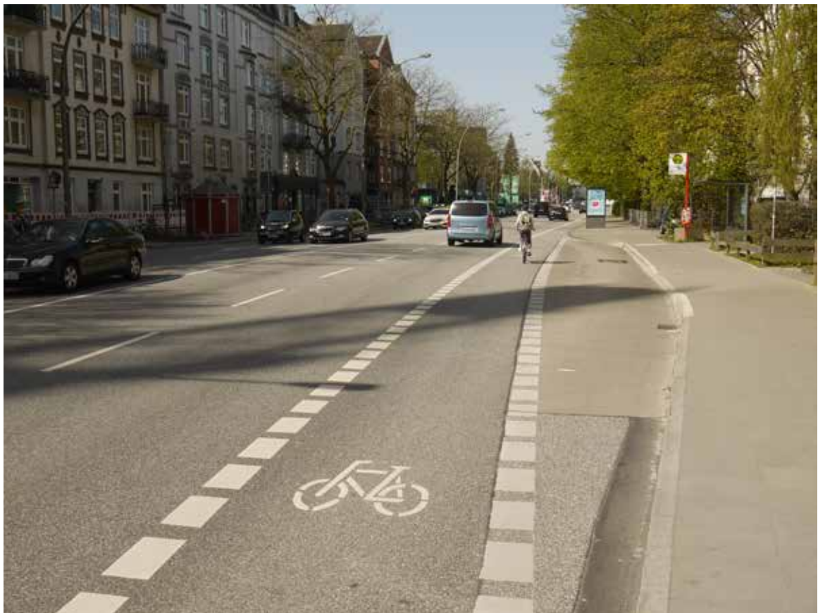
Bild 94: Stresemannstraße, Radfahrstreifen an Bushaltestelle
