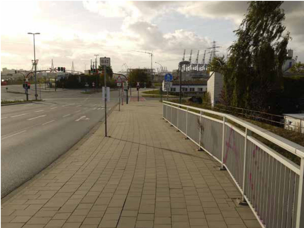
Bild 57: Reiherdamm (Velooute 11), gemeinsamer Geh- und Radweg
