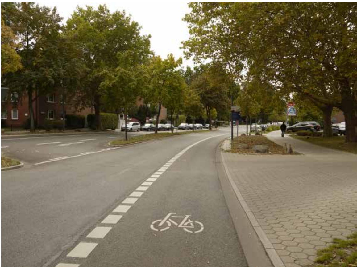
Bild 30: Steilshooper Straße (Veloroute 5), Radfahrstreifen
