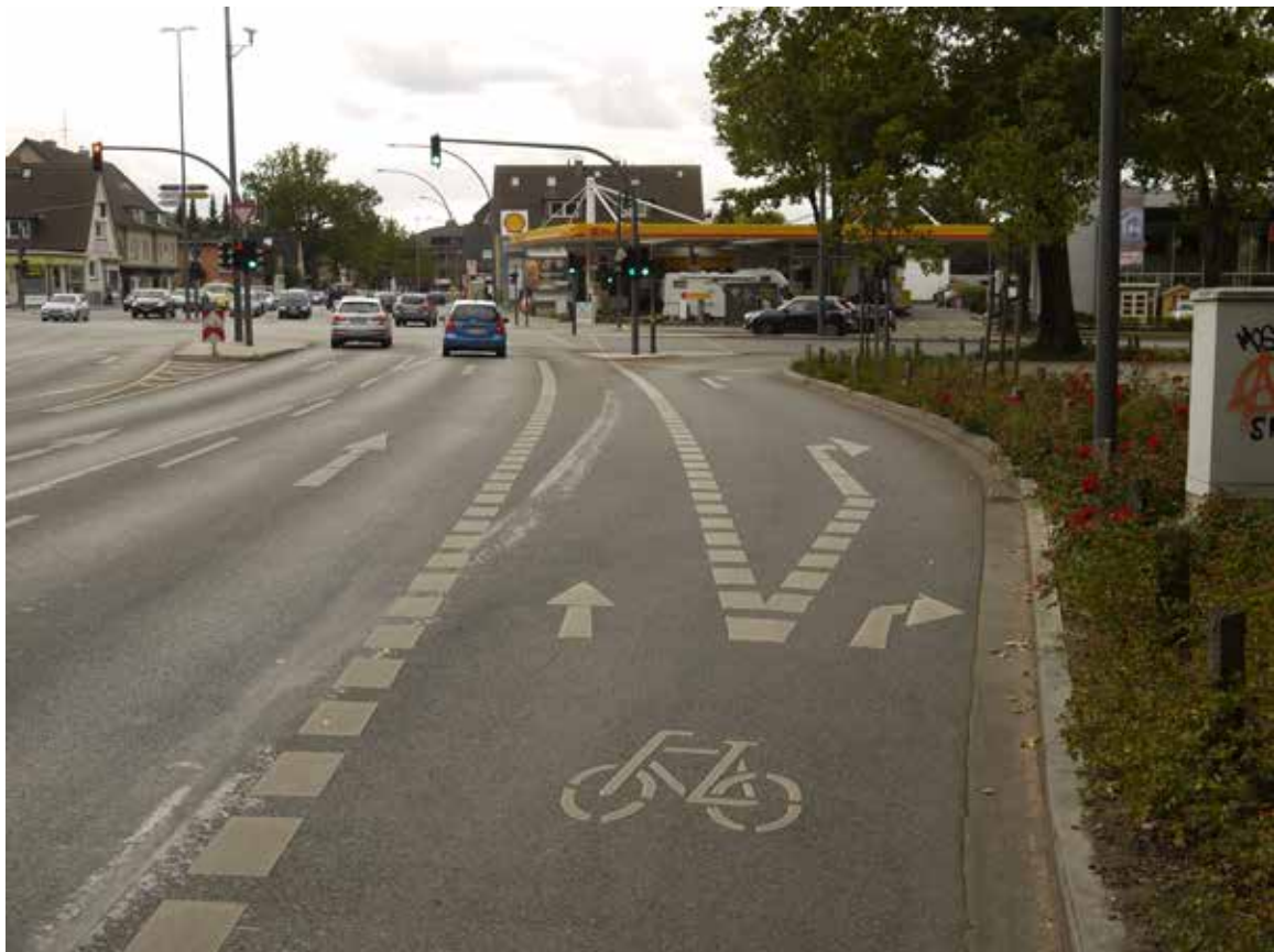
Bild 152: Stadtbahnstraße / Saseler Chaussee, Radfahrstreifen
