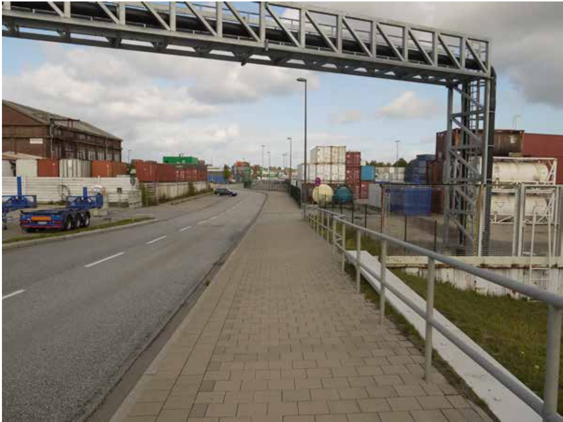
Bild 167: Altenwerder Damm, gemeinsamer Geh- und Radweg
