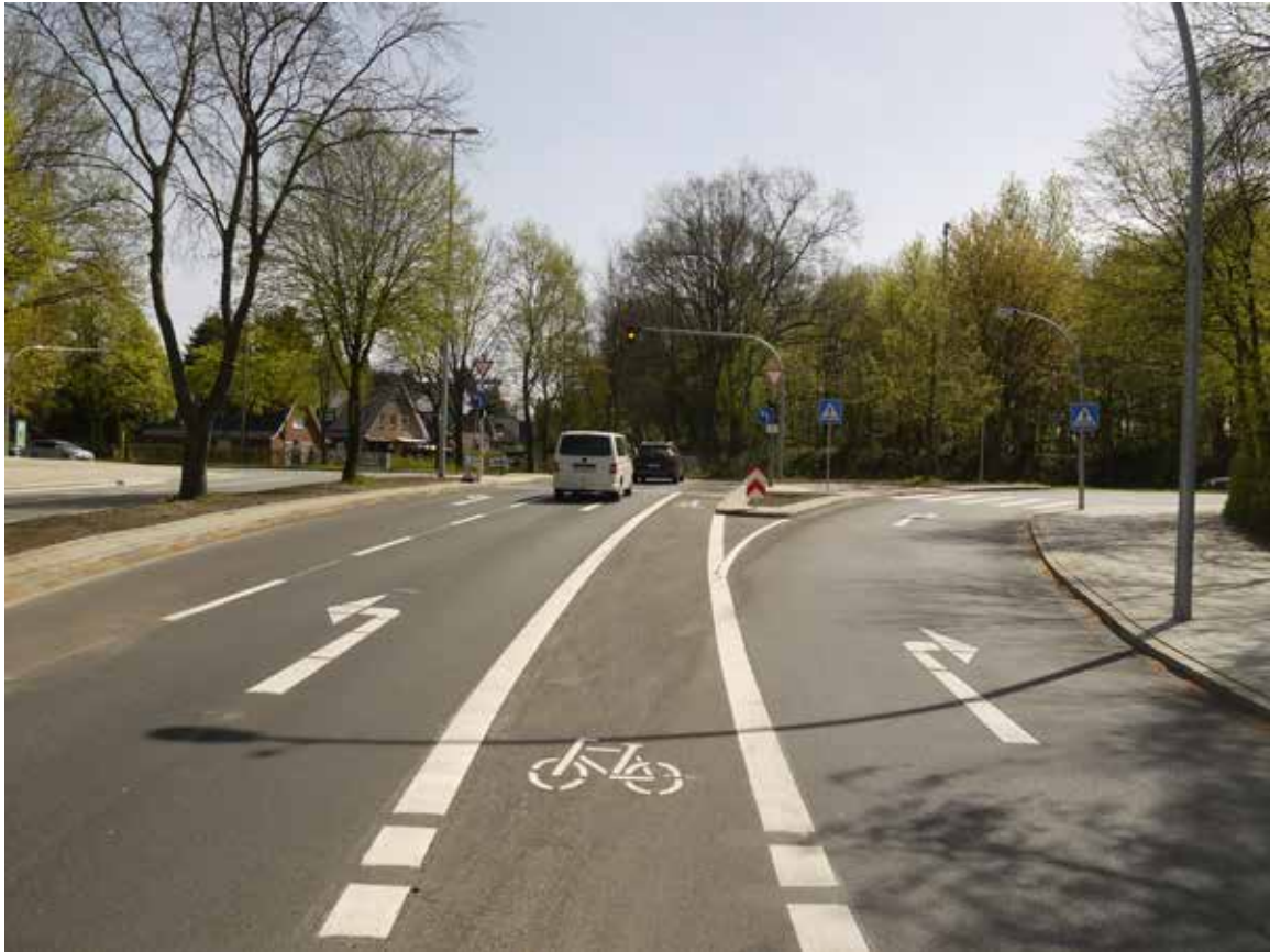
Bild 5: Bornheide (Veloroute 1) / Rugenbarg, Radfahrstreifen Richtung Grubenstieg
