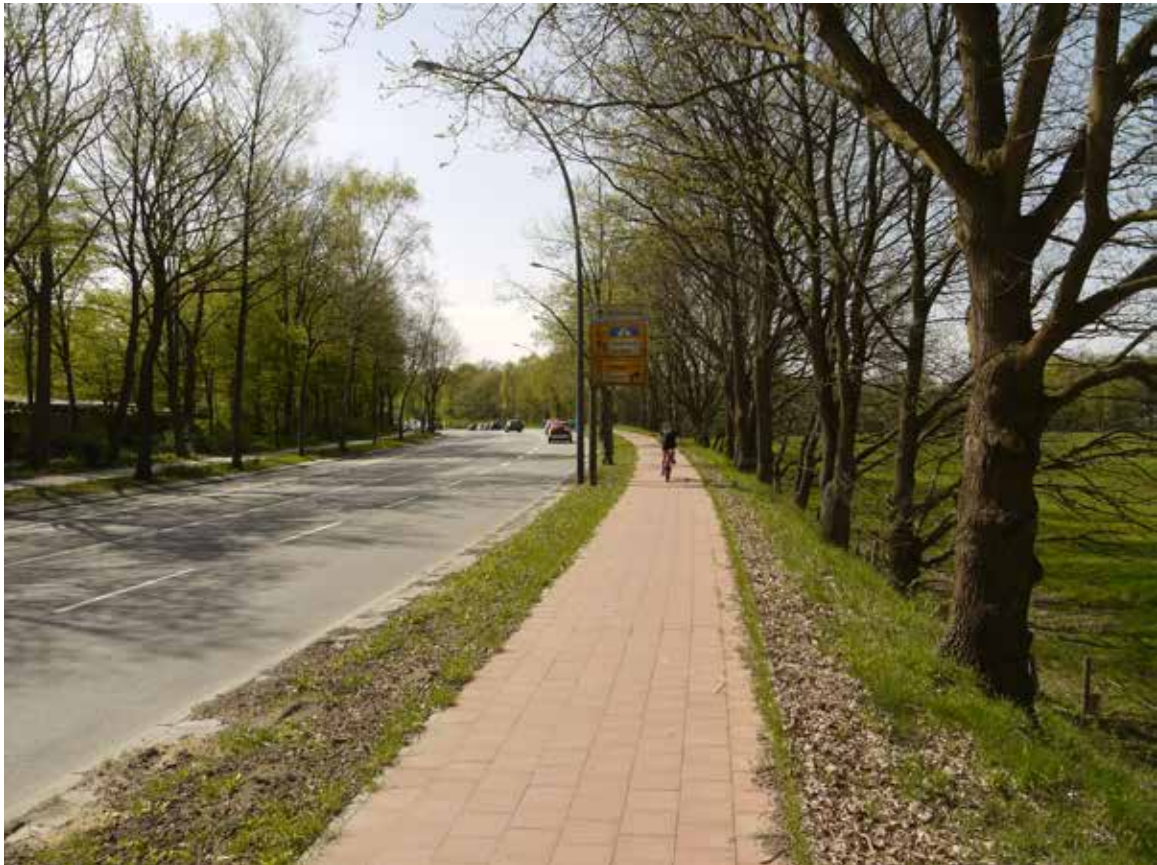
Bild 103: Rugenfeld, Instandsetzung des Radwegs
