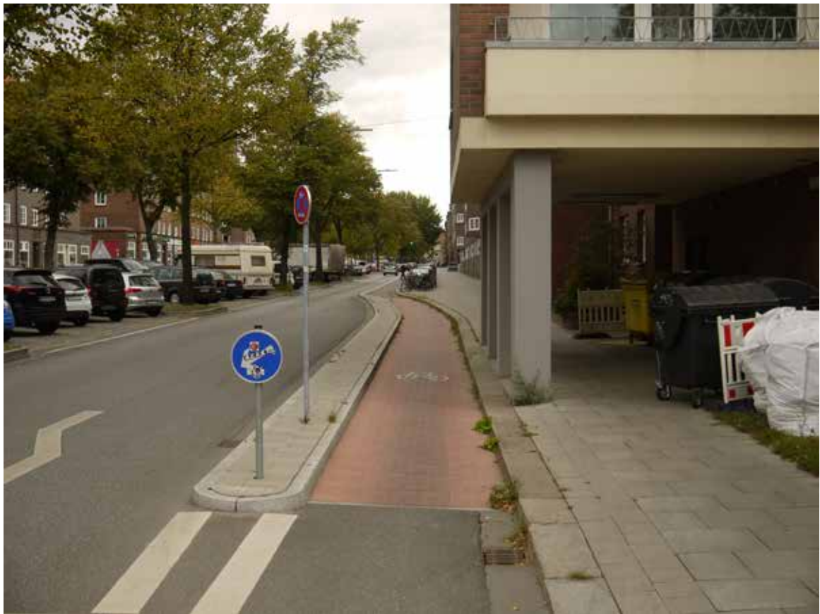
Bild 145: Straßburger Straße, Radweg
