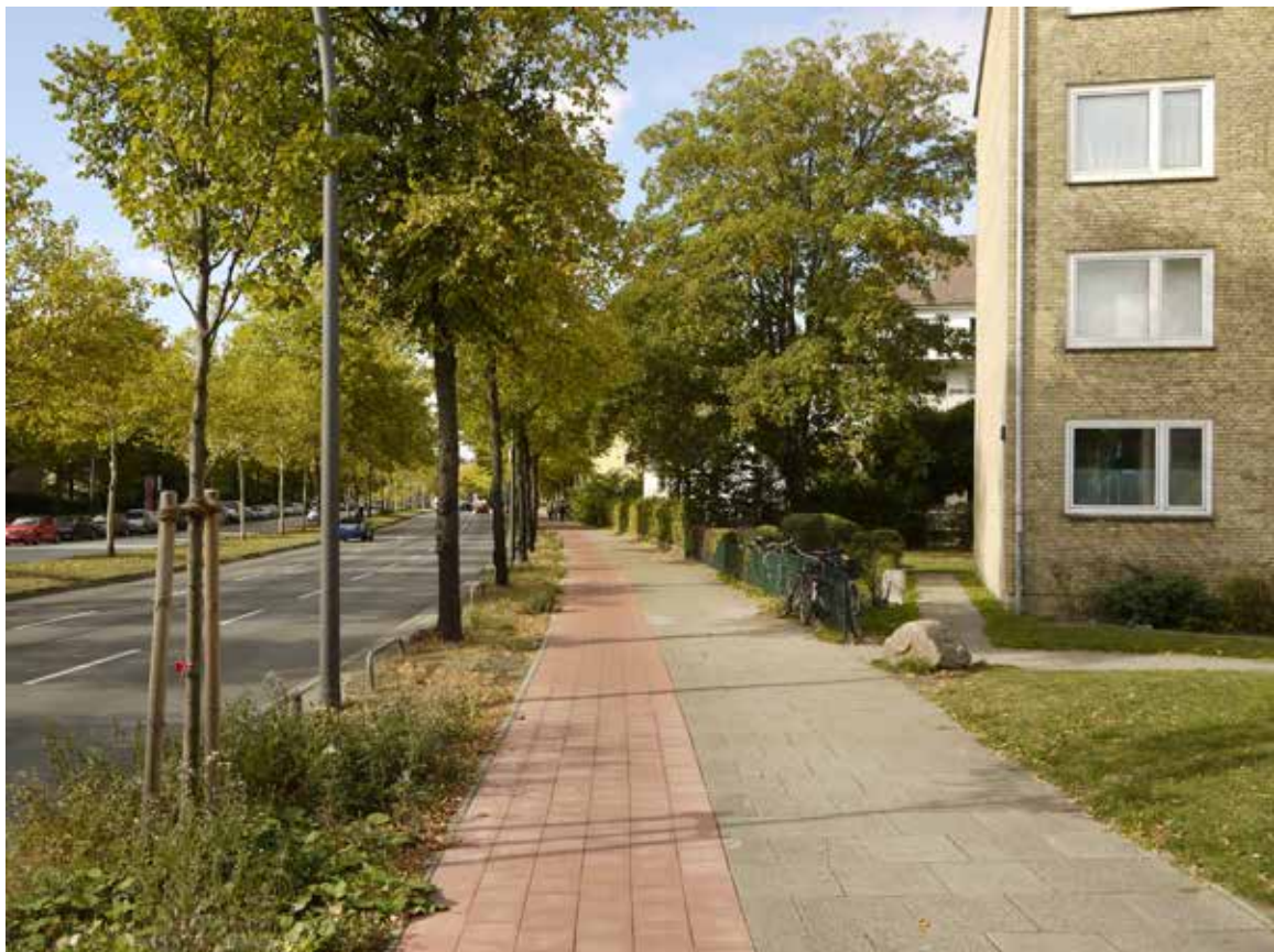
Bild 80: Sievekingsallee, Instandsetzung des Radwegs
