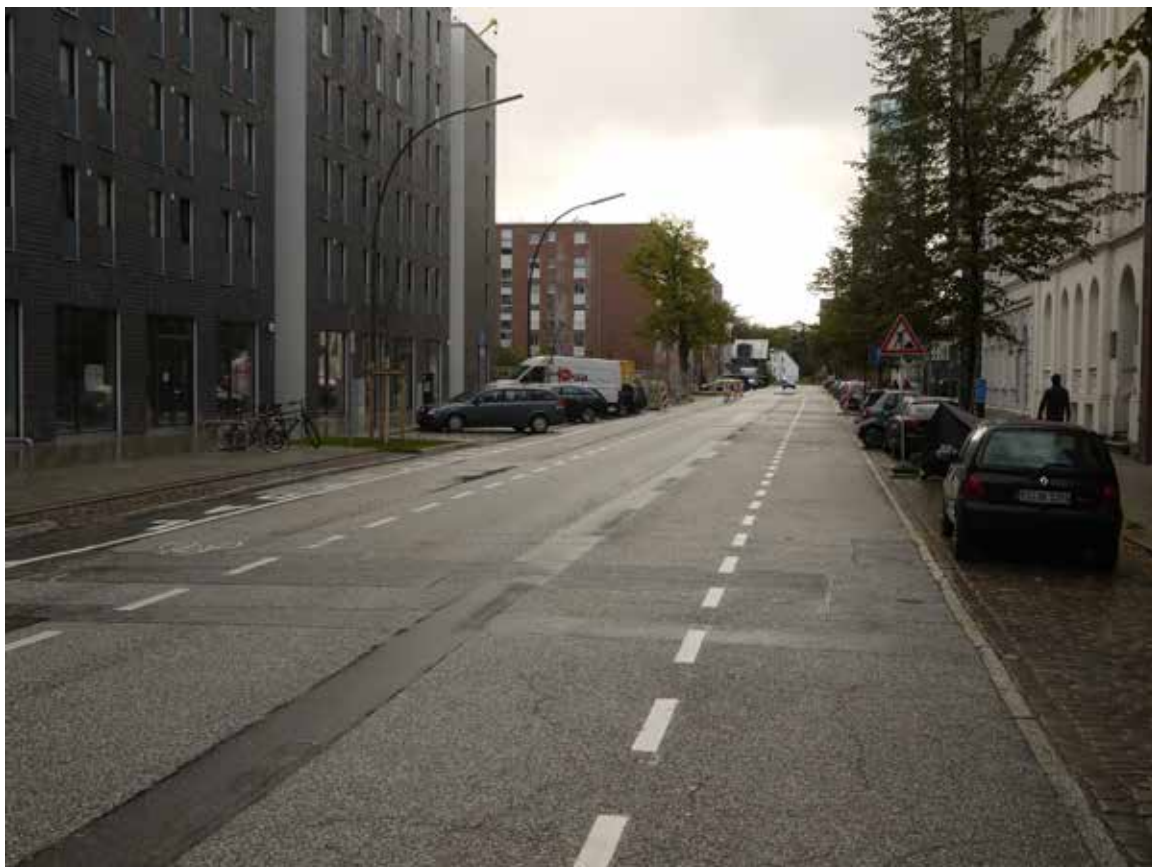
Bild 161: Schellerdamm, Schutzstreifen
