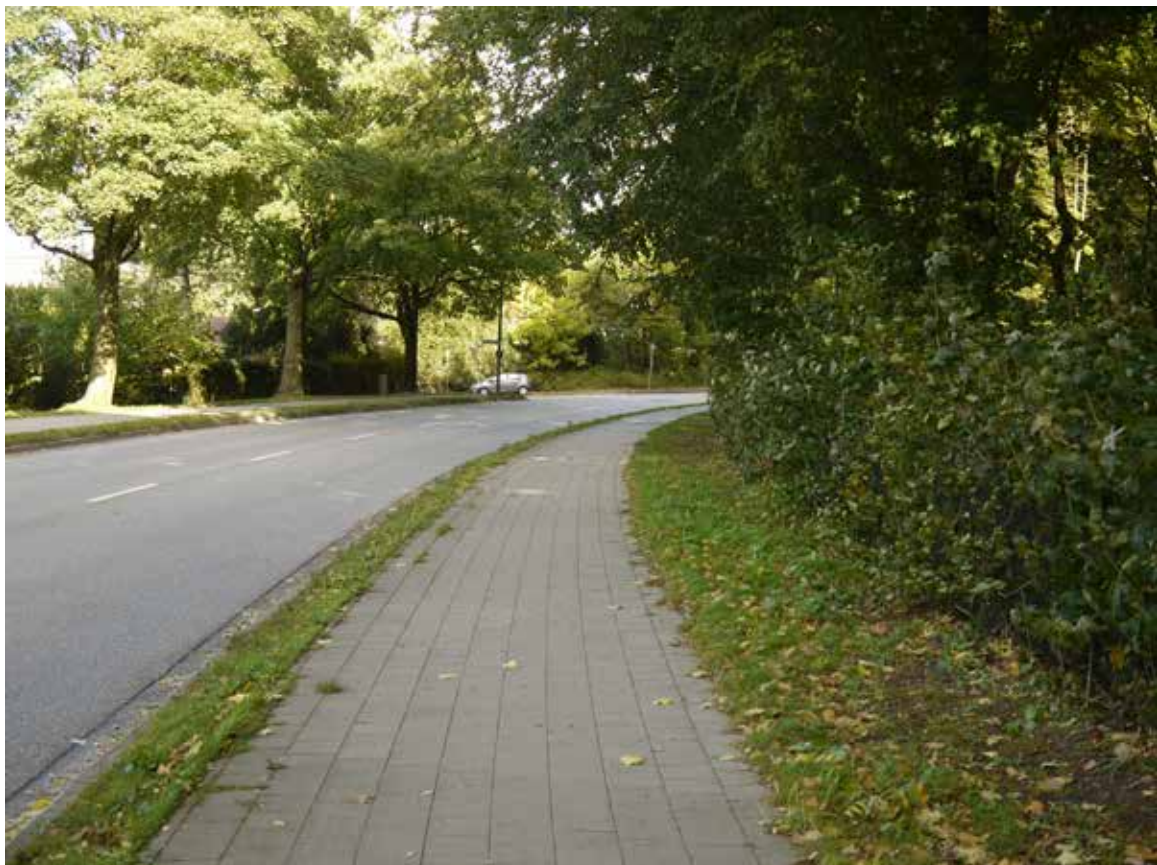
Bild 164: Bremer Straße, Instandsetzung der gemeinsamen Geh- und Radwege
