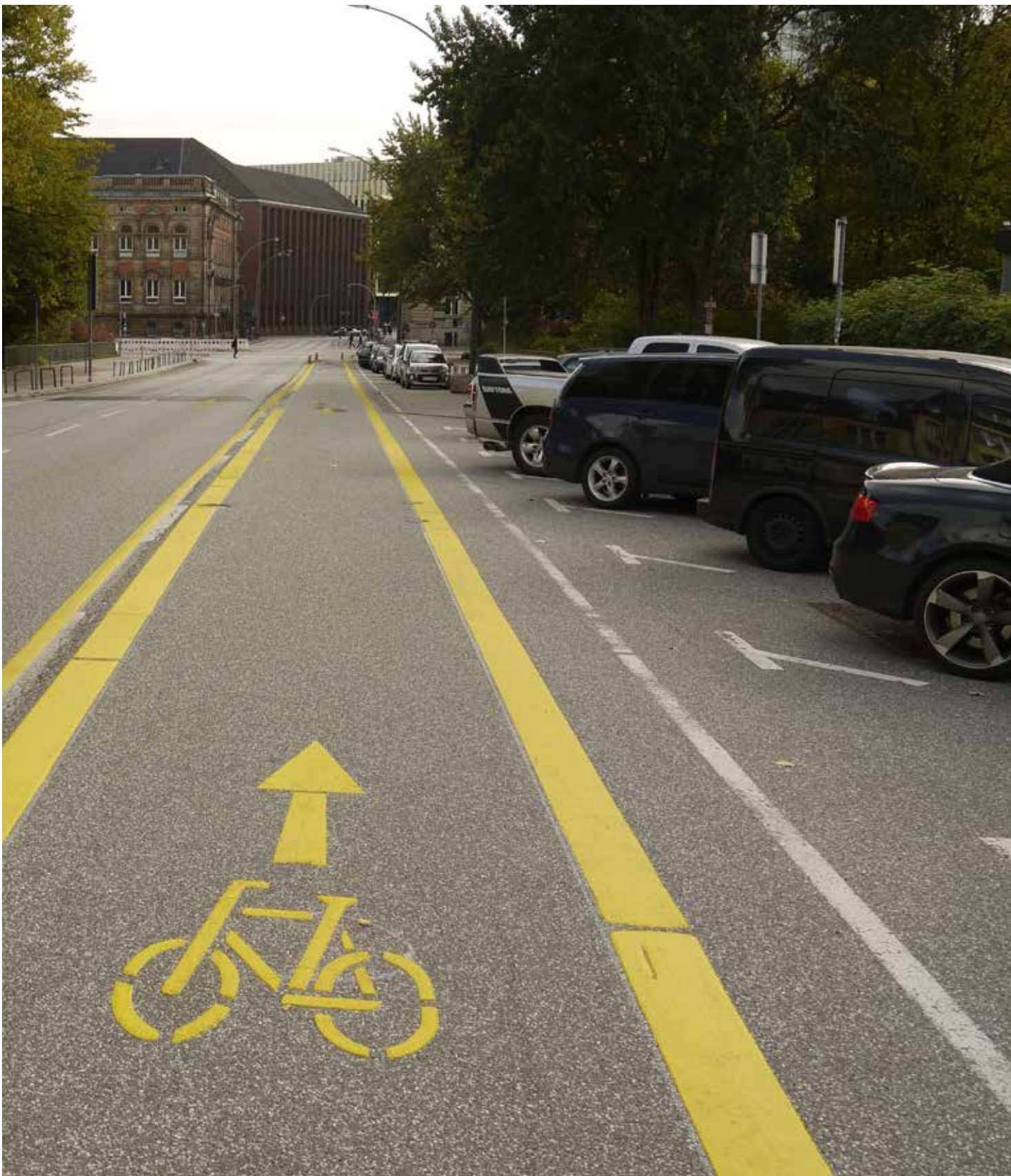
Bild 1.17: Baustellenbedingte Umfahrung der Tiergartenstraße über die Jungiusstraße (Bild: BWVI)
