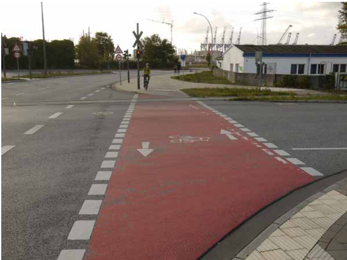
Bild 58: Reiherdamm (Veloroute 11), geradlinige Radverkehrsführung
