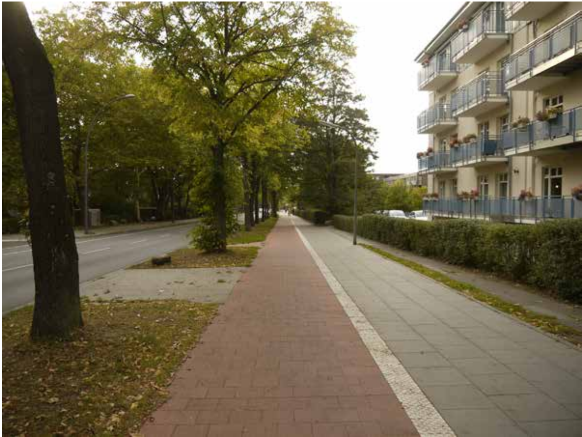
Bild 155: Scharbeutzer Straße, Radweg
