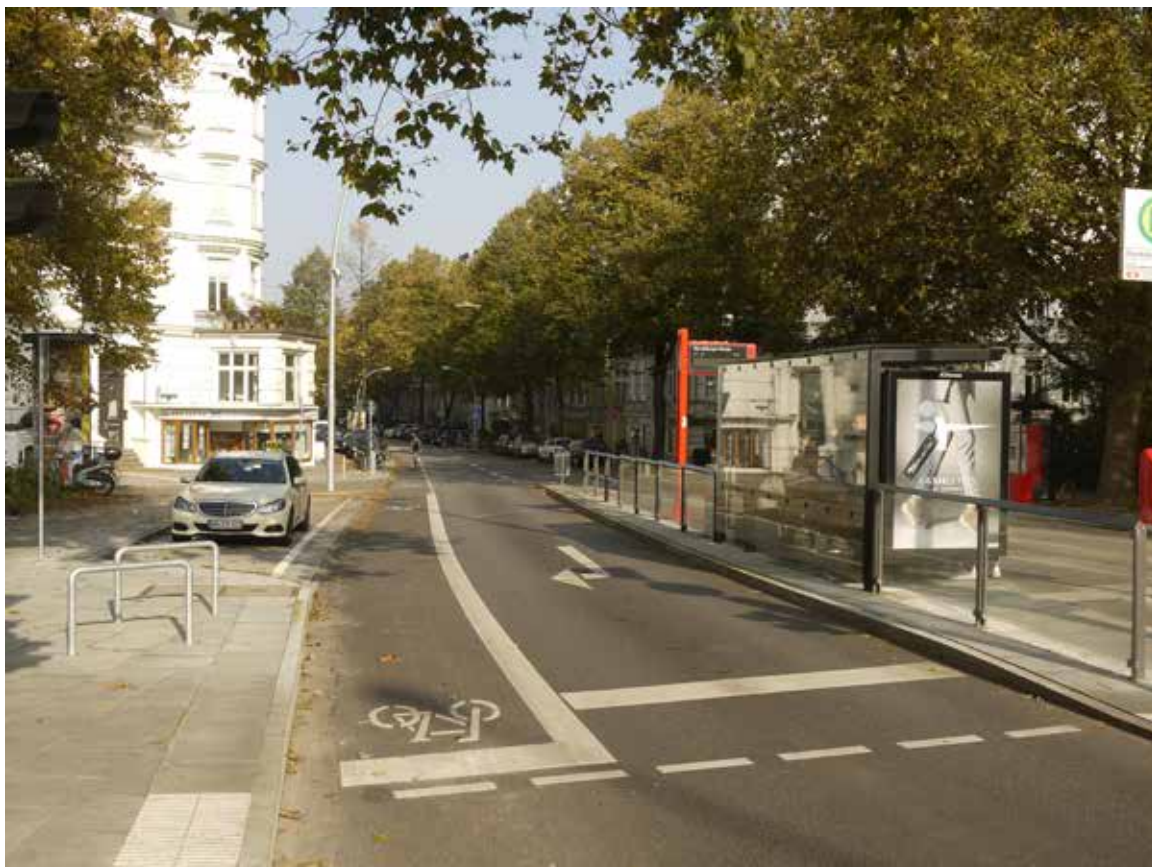
Bild 133: Papenhuder Straße, Radfahrstreifen
