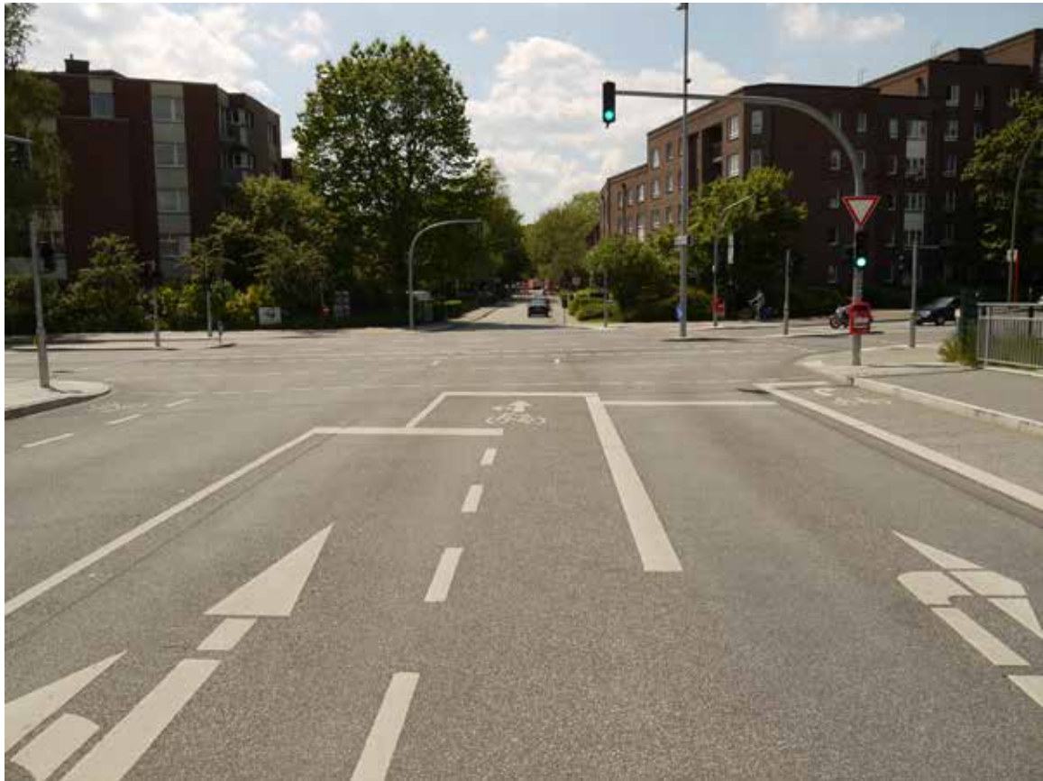
Bild 67: Öjendorfer Weg / Reclamstraße (Veloroute 14), Vorbeifahrstreifen
