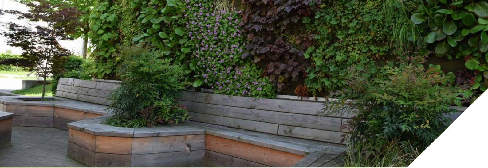
Ein flächiges System ist an einer WDVS-Putzfassade im Freiburger Turmcafé angebracht.
