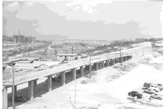
④北千里までの延伸工事の様子
