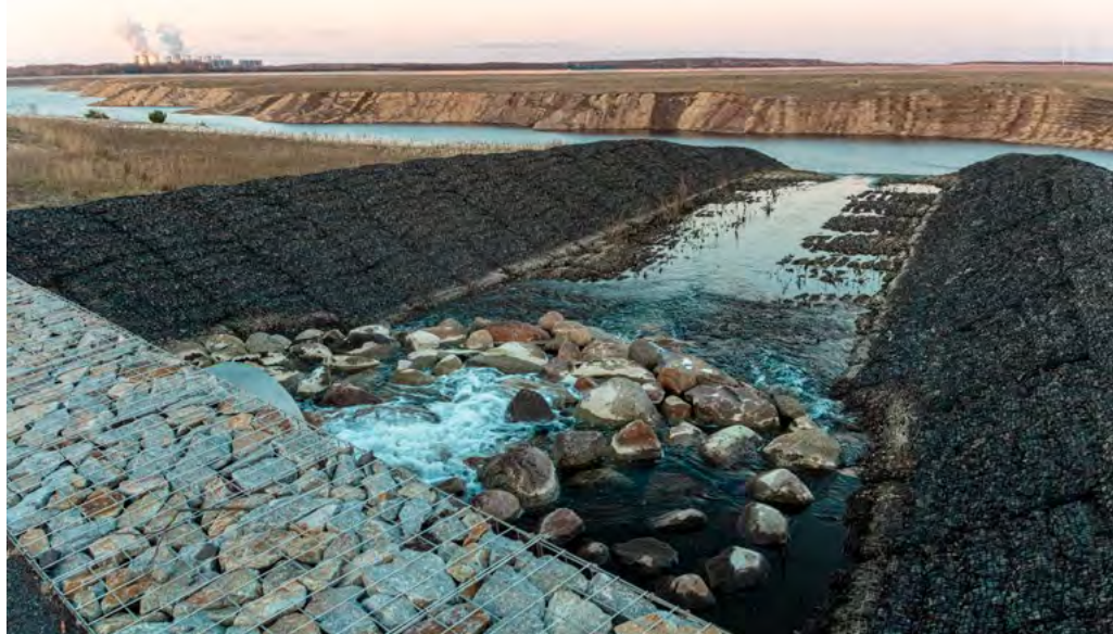
Am Einlaufbauwerk des Cottbuser Ostsees. Foto: TSPV
