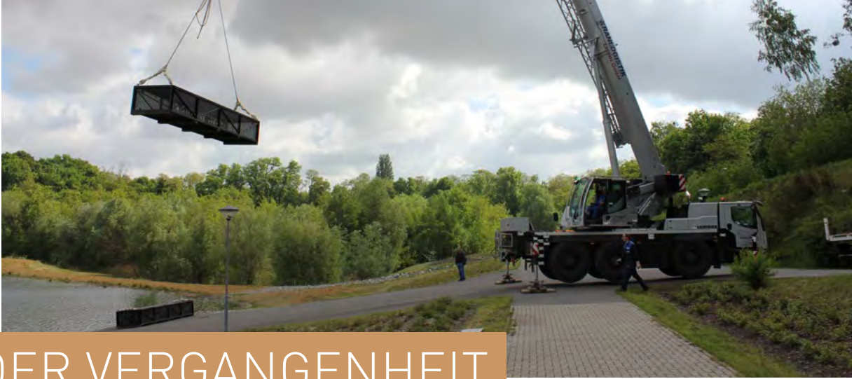
Versenken der Käfige, wo später die Holzfunde unter Wasser eingelagert werden.
