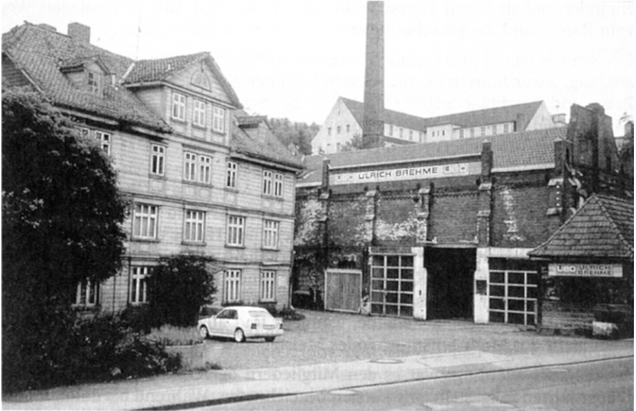
Abb. 1: Osterode, ehemaliges Betriebsgebäude der Coatingfabrik (Tuchfabrik) von Schöttler & Schröder, um 1830. Als eines der wenigen Textilunternehmen versuchte sich diese Fabrik zu Beginn der 1830er Jahre auch im Textilmaschinenbau. Ihr Gelände wurde Ende der 1880er Jahre vom Hamburger Wollwarenhersteller von Allwörden & Badendieck übernommen und ausgebaut. (Aufnahme des Verfassers, Mai 1992)
