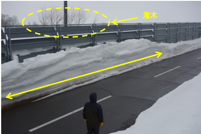
写真2 吹き払い柵の風上側に灌木のある箇所で、柵風下側の堆雪量が大きくなっている。吹き払い機能が低下し、道路上に吹きだまったことがわかる(2015年3月)。
