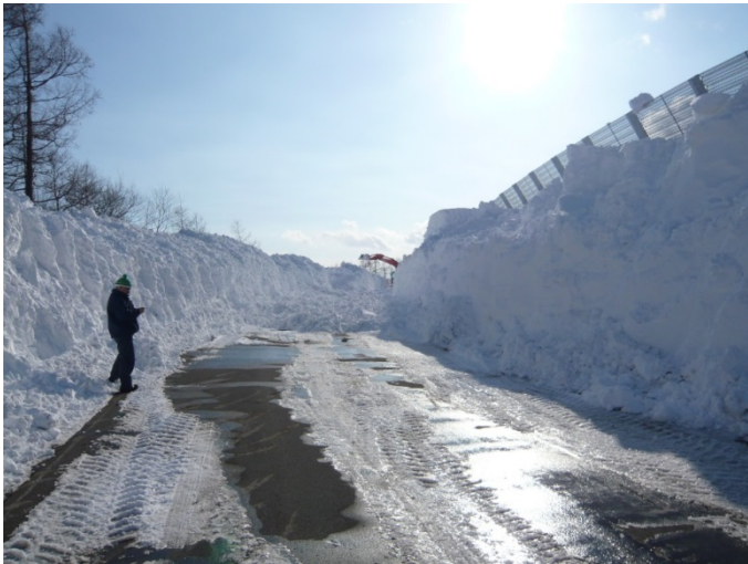
写真10 吹き止め柵。柵の防雪容量を超え、路上にも柵高近くまで、吹きだまりが形成された(2014年2月)。
