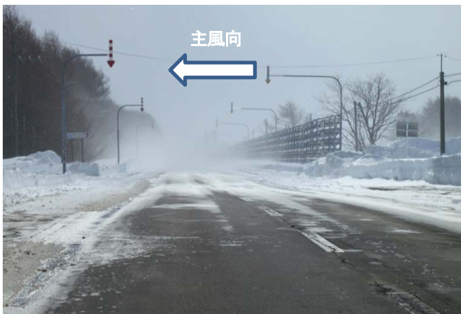
写真6 吹き払い柵の風下側の樹林帯が吹き払い機能に影響を与えている事例(2013年3月)。
