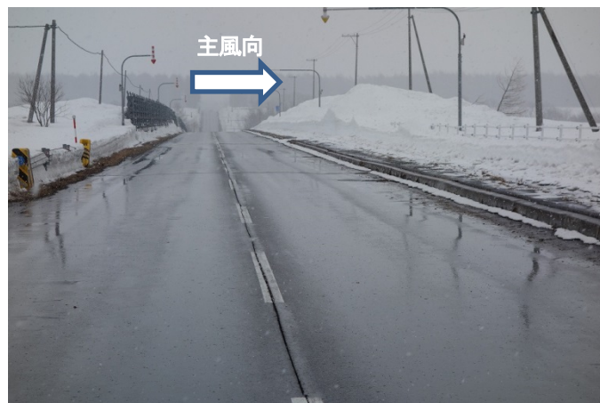
写真8 吹き払い柵未設置区間には顕著な吹きだまりは見られないが(写真手前)、吹き払い柵設置区間の風下側には大きな吹きだまりが形成されている(2015年3月)。
