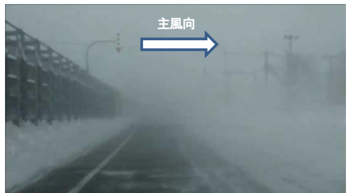
写真5 道路風下側路側の雪堤が吹き払い柵の吹き払い機能に与えている影響。上：雪堤がない場合、下：風下側路側に雪堤がある場合。
