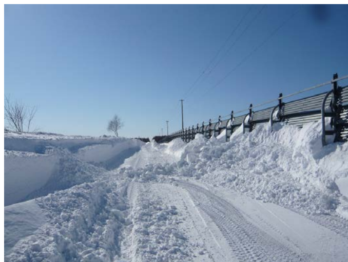
写真9 吹き払い柵。風上側の積雪深も柵高近くに達しており、吹き払い機能は完全に失われている(2015年2月)。
