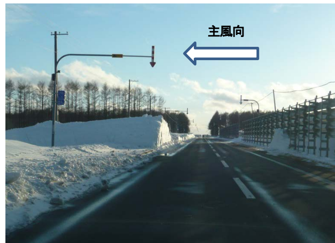
写真3 吹き払い柵の風上側にある障害物が吹き払い機能に影響を与えた事例。吹き払い柵の風下側に巨大な吹きだまりが形成されていた（2014年2月）。
