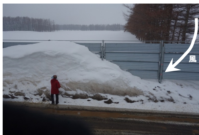
写真1 吹き払い柵の風上側の樹林が吹き払い機能に影響を与えている事例（2015年3月）。
