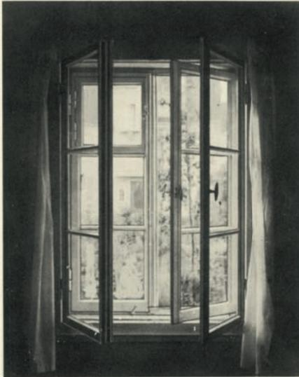
Anschluß des Fensters in einem Holzfachwerkbau. Zu beachten sind die genau durchdachten Einzelheiten, z. B. Maueranschlag, Putzanschlüsse und Anschlag des Ladens
