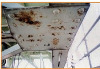
鉄筋の露出している管理橋・堰柱
