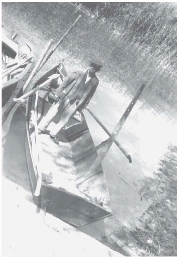
Abb. 54: Die Fischerbarche in Erlach (BE 27) wird stehend gerudert. Bei einem Mann Besatzung werden zwei Stehruder eingesetzt, wobei die Ruder vor der Brust des Rudersers gekreuzt sind. Bei mehrköpfiger Besatzung wird pro Person nur ein Ruder bedient. [Quelle: SDS]
