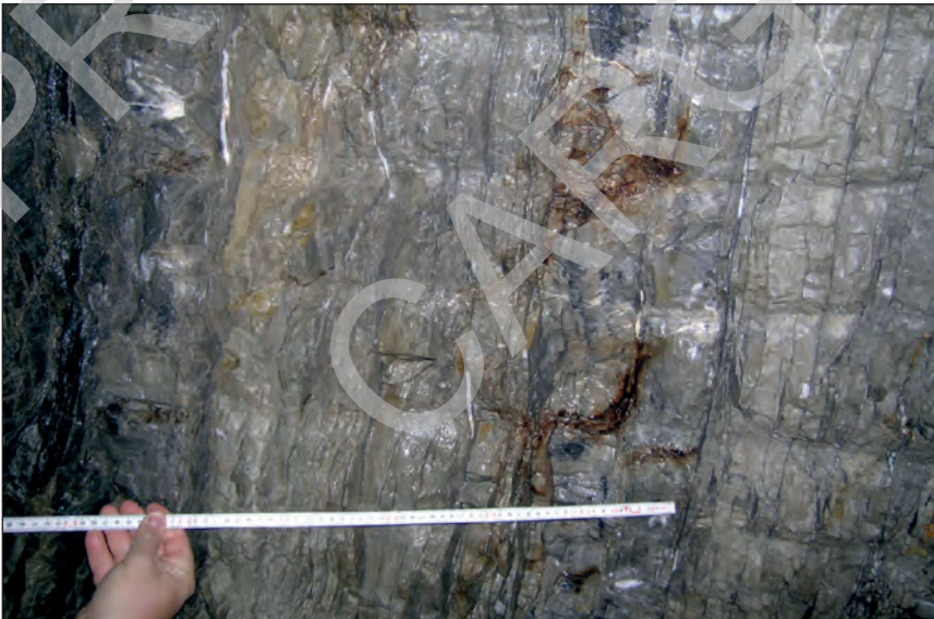
Abb. 42 – Dunkelgraue, plattige Kalke innerhalb der Scaglia Variegata Alpina, im Speicherstollen „Acquasanta“ (Sporminore). Man erkennt das Steinöl, das auf natürliche Art und Weise aus dem Fels dringt.
