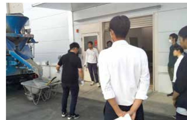
生コンクリート受入検査の実演
