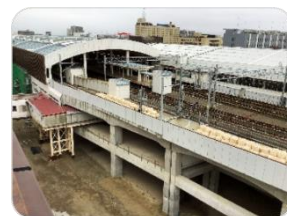
新潟駅在来線全線高架化
