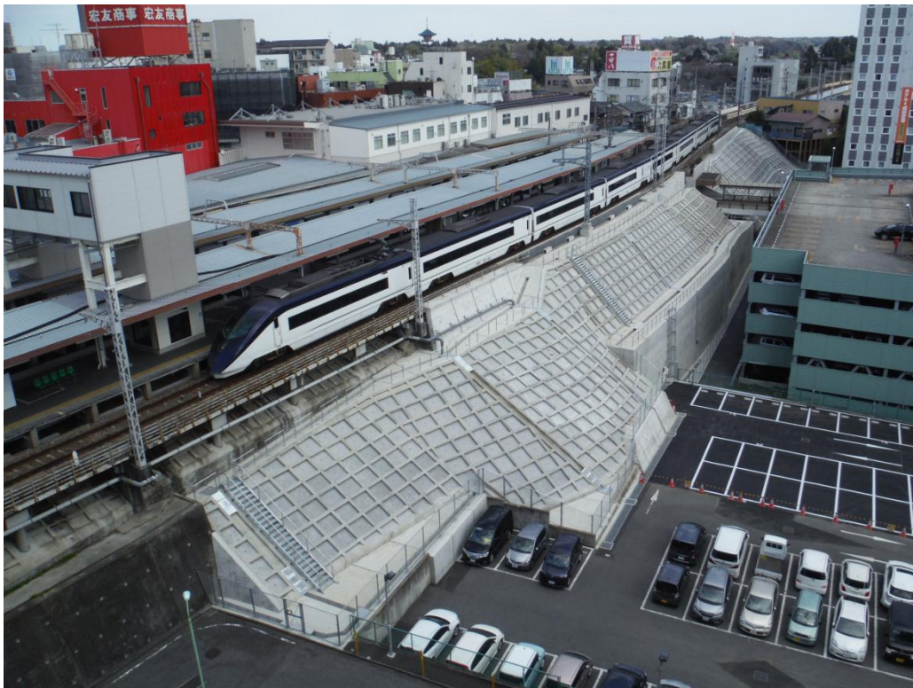
法面の補強工事が完了した京成成田駅
