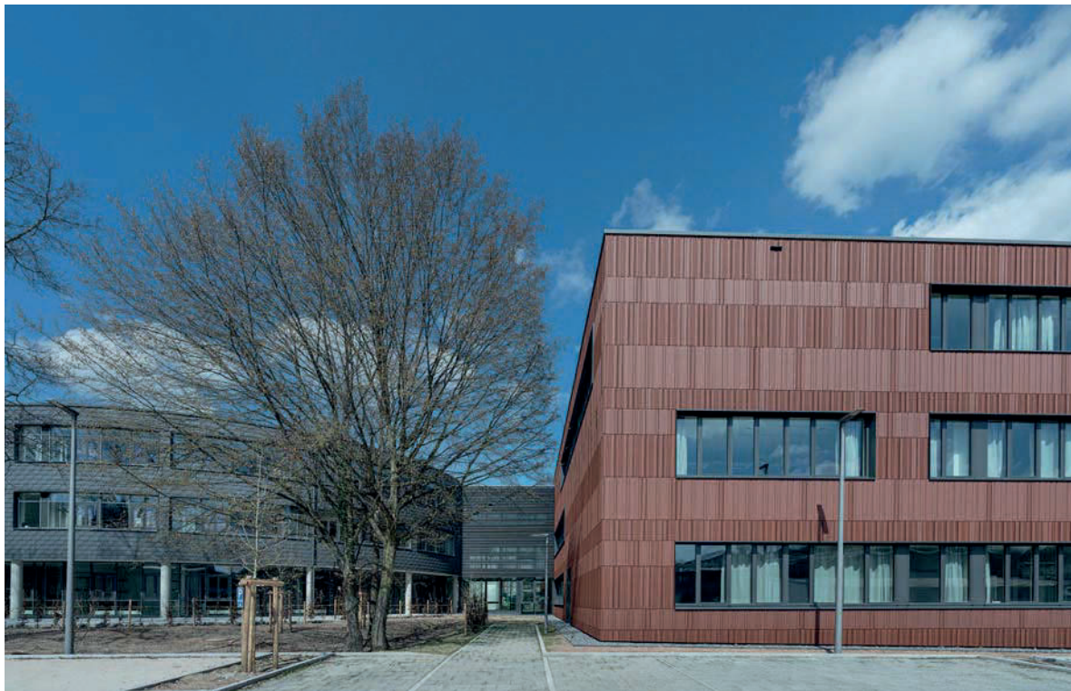
Blick von Süden auf den renovierten Rundbau und den Neubau
