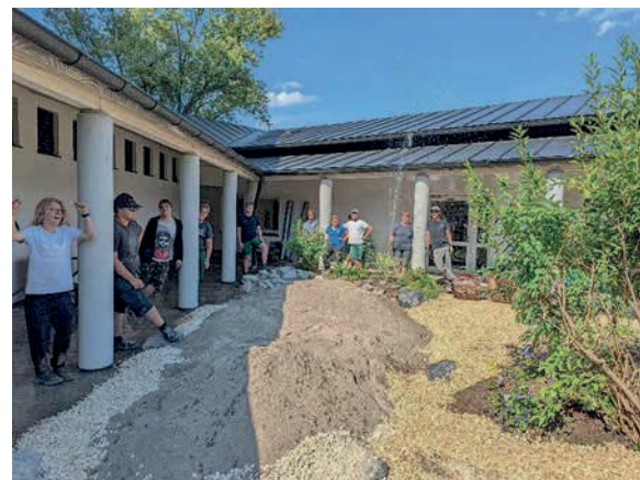
Baumaßnahmen im Innenhof Arkadencafé
