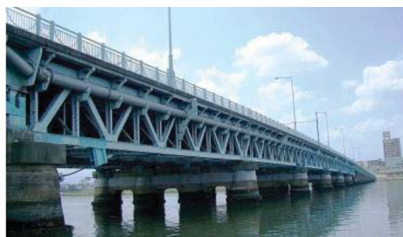
写真1 対象橋梁の外見
