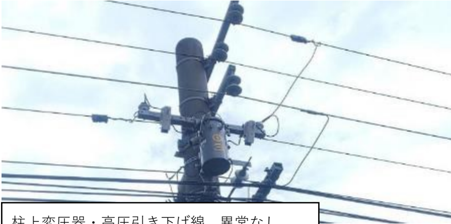
柱上変圧器・高圧引き下げ線 異常なし
