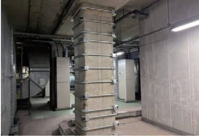
▲耐震補強工事を施した地下部の柱
