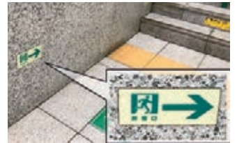
▲蓄光式避難誘導明示物
