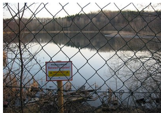
Abb. 48 - Schlammteich 4 in Freital-Döhlen, vor der Sanierung im Jahr 2004 © Foto S. Janetz 2004
