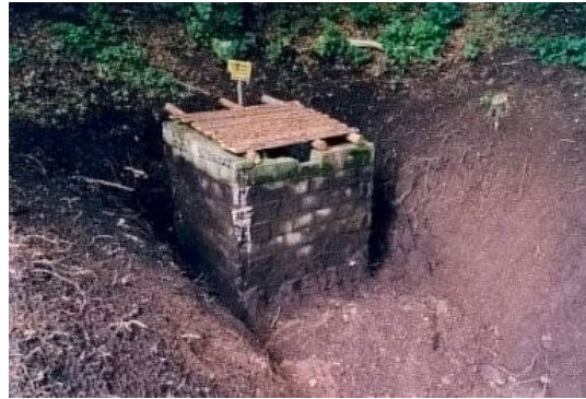
Abb. 56 - Freigelegte Schrotummauerung des Mundloches während der Rekonstruktionsarbeiten 2001 © Foto S. Stute
