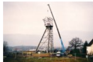
Abb. 66 - Montage - Fördergerüst 1 Freital-Burgk © Foto S. Stute
