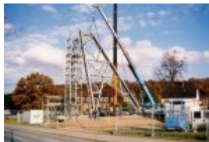
Abb. 65 - Montage - Fördergerüst 1 Freital-Burgk © Foto S. Stute
