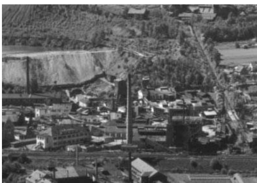
Abb. 47 - Die Fabrik 93 zwischen Döhlener Gussstahlwerk und Kohlenwäsche, Blick vom Windberg um 1955 © SLUB Fotothek Dresden (Möbius)
