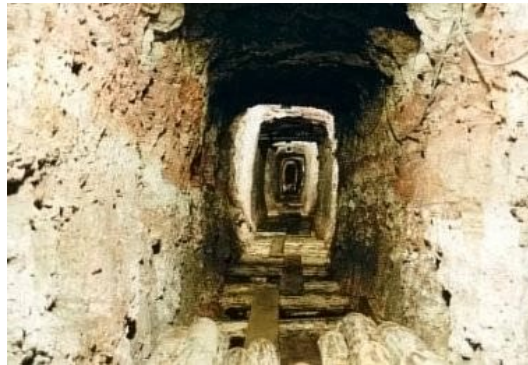
Abb. 57 - Blick in den untertägigen Bereich der Rösche (Rotliegendensedimente) im September 2002 © Foto S. Stute
