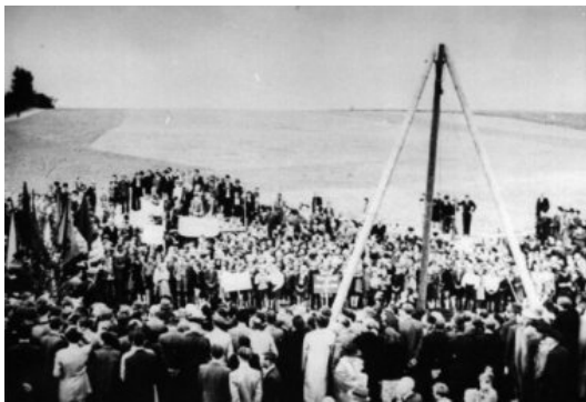
Abb. 35 - Teufbeginn der Schachtanlage Dresden-Gittersee 1950 © Museum Städtische Sammlungen Schloß Burgk
