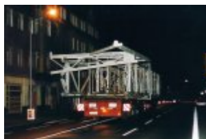
Abb. 71 - Demontage Fördergerüst 2 Dresden-Gittersee © Foto S. Stute
