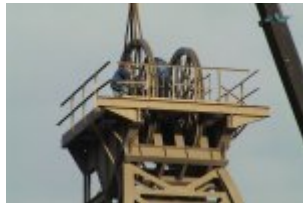
Abb. 61 - Montage der Seilscheiben von Fördergerüst 1 © Foto S. Stute
