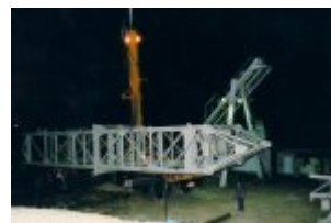
Abb. 72 - Transport Fördergerüst 2 nach Freital-Zauckerode © Foto S. Stute
