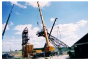
Abb. 68 - Demontage Fördergerüst 2 Dresden-Gittersee © Foto S. Stute
