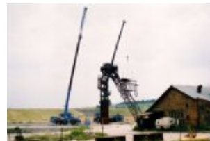
Abb. 69 - Demontage Fördergerüst 2 Dresden-Gittersee © Foto S. Stute
