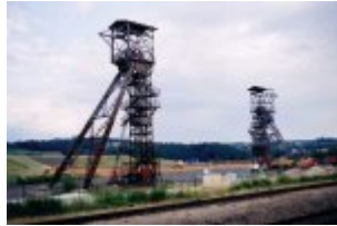
Abb. 58 - Fördergerüste am Standort in Gittersee © Foto S. Stute
