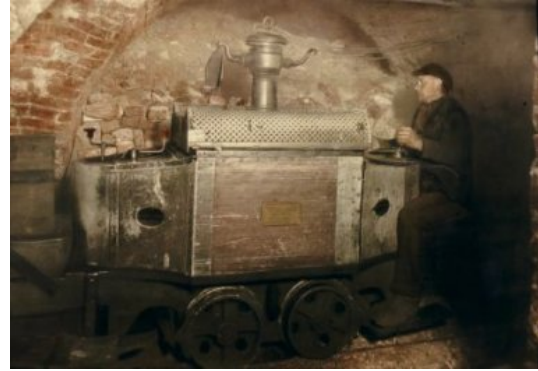
Abb. 51 - Die elektrische Grubenlokomotive im 5. Hauptquerschlag des Oppelschachtes um 1900 © Museum Städtische Sammlungen Schloß Burgk
