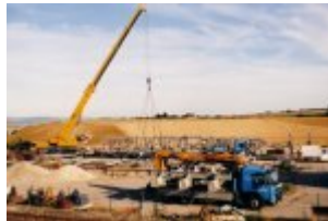
Abb. 62 - Verladung Fördergerüst 1 Dresden Gittersee © Foto S. Stute
