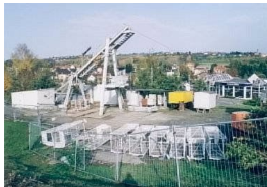
Abb. 54 - Zugangsschacht zum Tiefen Elbstolln (Untersuchungsgesenk 10 der Wismut GmbH) in Freital-Zauckerode © Foto S. Stute
