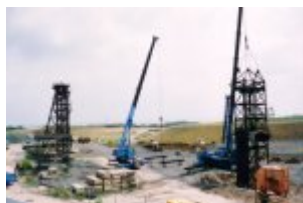
Abb. 70 - Demontage Fördergerüst 2 Dresden-Gittersee © Foto S. Stute
