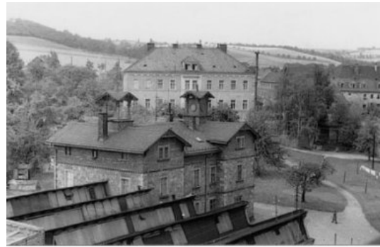
Abb. 27 - Historische Aufnahme des Opper-Schachtes in Freital-Zuckerode, im Vordergrund die ehemalige Kohlenexpedition © Museum Städtische Sammlungen Schloß Burgk
