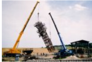
Abb. 59 - Demontage des Fördergerüst Schacht 1 © Foto S. Stute
