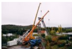
Abb. 73 - Montage Fördergerüst 2 Freital-Zauckerode © Foto S. Stute
