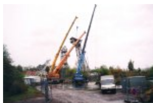
Abb. 74 - Montage Fördergerüst 2 Freital-Zauckerode © Foto S. Stute
