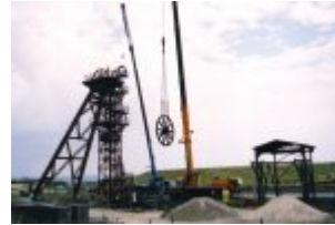
Abb. 60 - Demontage des Fördergerüst Schacht 1 © Foto S. Stute
