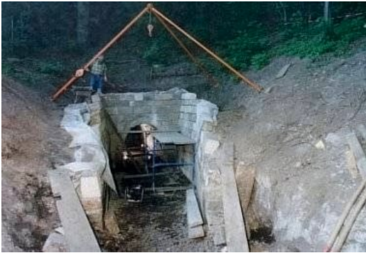
Abb. 55 - Setzen der Sandsteinmauerung durch die GABS Freital als Hangsicherung am Mundlochbereich der Rösche 2001 © Foto V. Haustein
