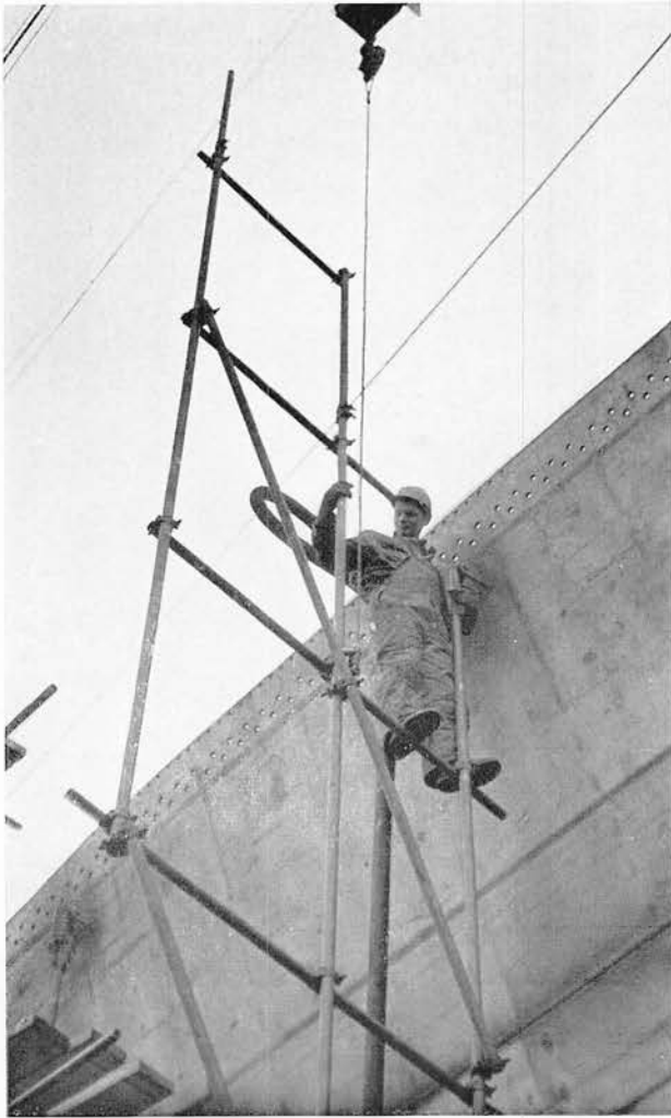
Erich Heitmann beim Aufhängen von Rohrhängern
