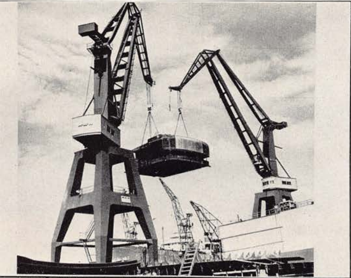
Aufsetzen eines 80 t Aufbaues
