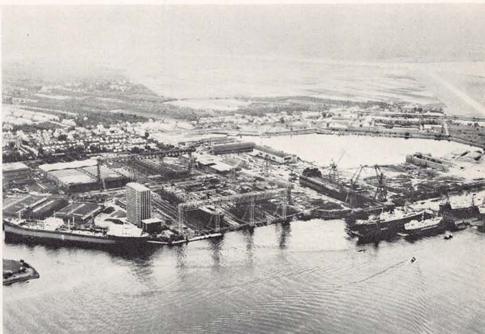
SOMMER 1960: Luftaufnahme des Westteils der Deutsche Werft, Finkenwerder. Die Aufnahme umfaßt die 8 Neubauhelgen mit dem neuen Großhelgen für Schiffe bis 100 000 t d w und mehr, die neue Schiffbauwerkstatt für schwere Bleche und einen Teil unserer Schwimmdockanlagen für Schiffe bis 65 000 t. Der Südrand des Werftgeländes zeigt einen Teil der Wohnsiedlungen der Deutsche Werft.
