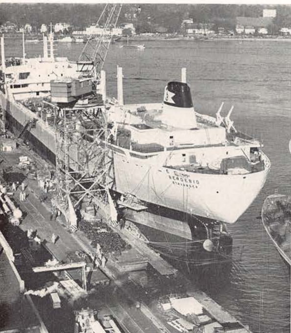
HERBST 1960: Nordteil des etwa 800 m langen Ausrüstungshafens mit einem 47 000 tdw großen Turbinen-Tanker im Ausbau
