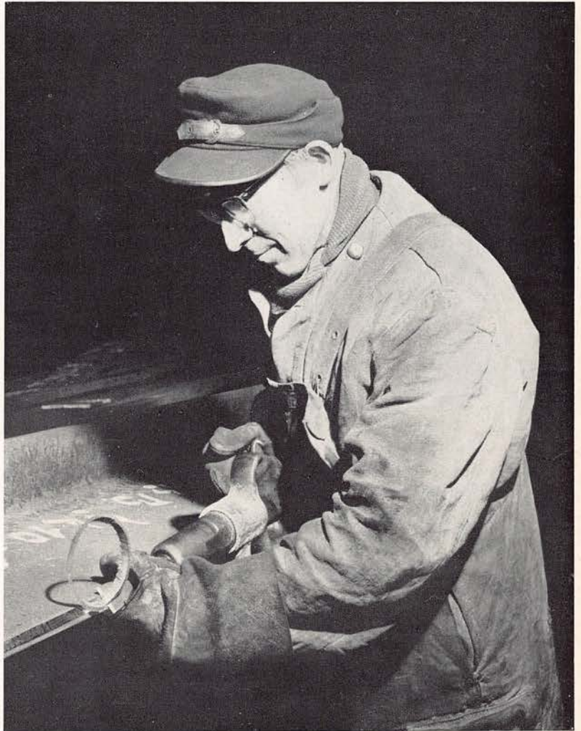
Heinrich Barvels behaut ein Bodenlängsspant
