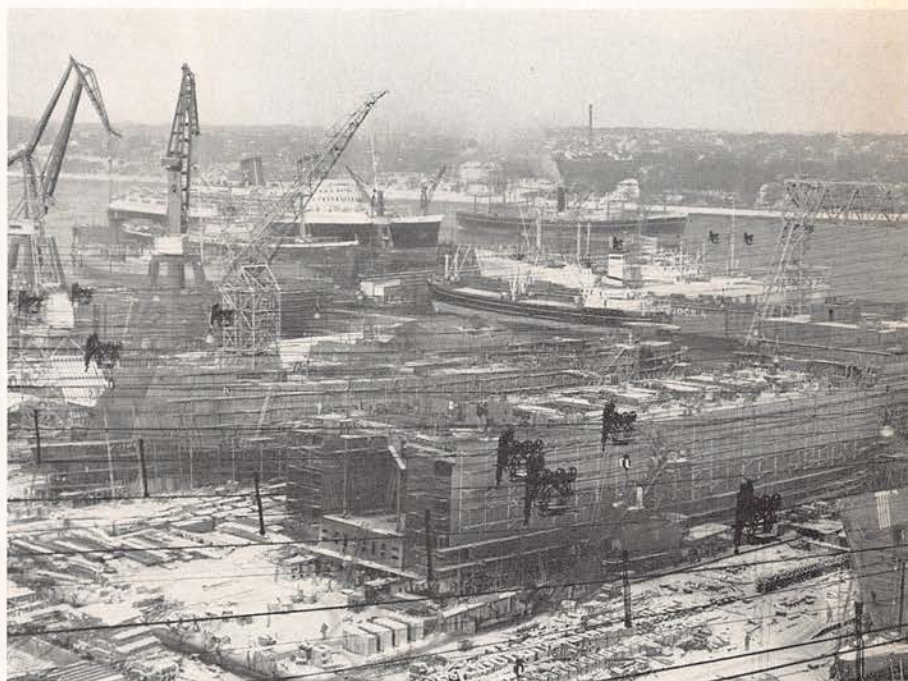
WINTER 1960: Blick auf die Neubau-Helgen von 270 m Länge von der Landseite mit dem großen Fahrgastschiff „HANSEATIC“ im Dock V
