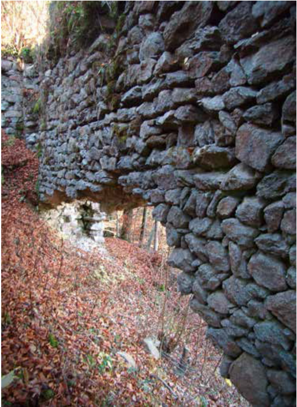
Bruchsteinmauerwerk der Hauptburg mit deutlichen Spuren von Raubabbau.
