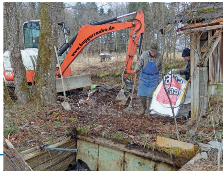
Abriss der Fischerhütte
