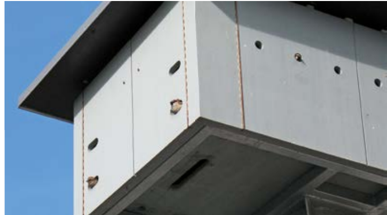
Der Spatzenturm an der Höltystraße – drei Bewohner zeigen sich gerade an den Einfluglöchern.
