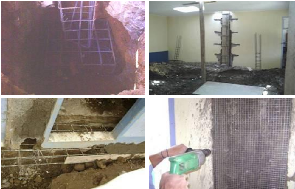
Gambar 29. Tahapan-tahapan dalam pekerjaan fisik perkuatan bangunan.
