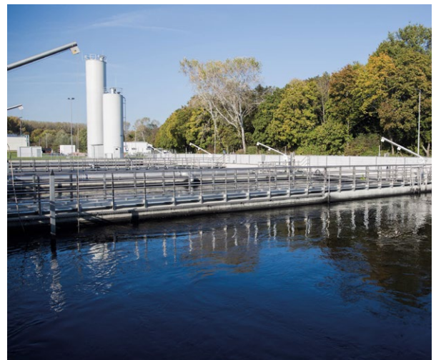
Pulveraktivkohle-Anlage mit zwei Aktivkohlesilos
