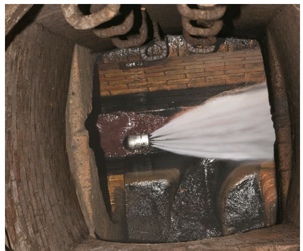
Kanalreinigung mit Hochdruckspüldüse
