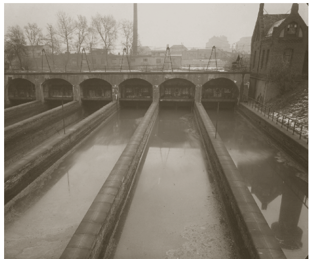
Die erste Kläranlage auf der Friesenheimer Insel
