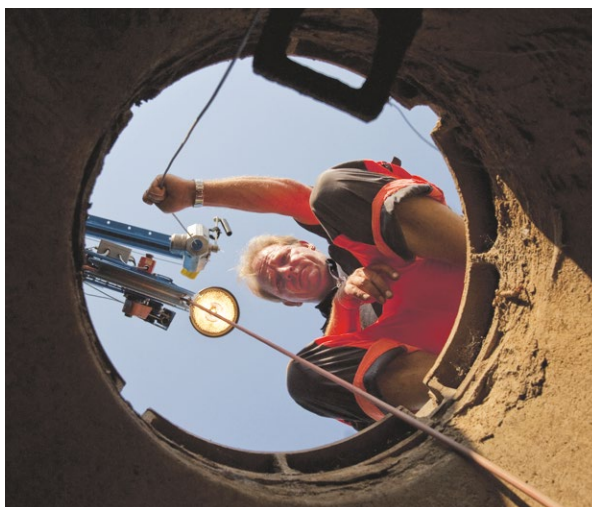
Vorbereitung der Kanaluntersuchung mit der Kamera
