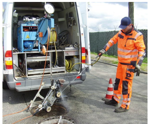
Reinigung der Kanalkamera
