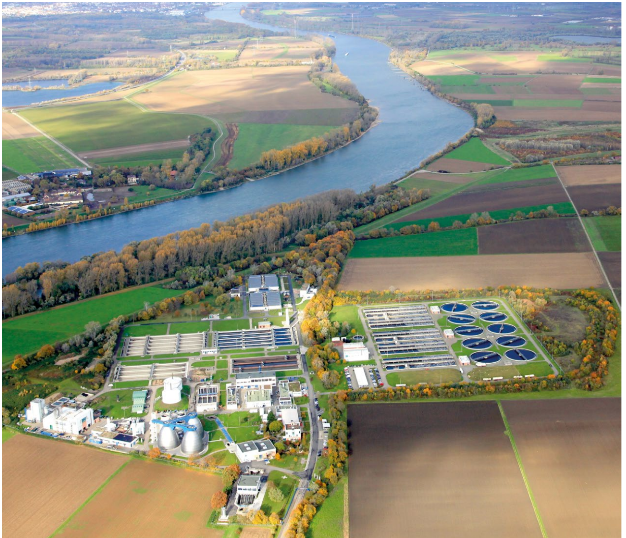
Luftbild des Klärwerks 2019
