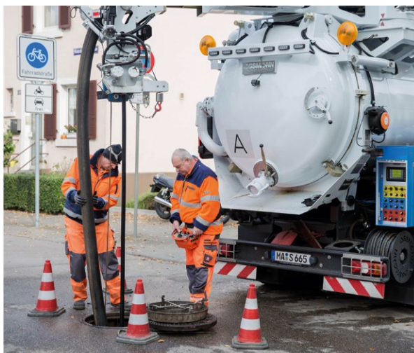
Reinigungsteam bei der Vorbereitung am offenen Kanalschacht
