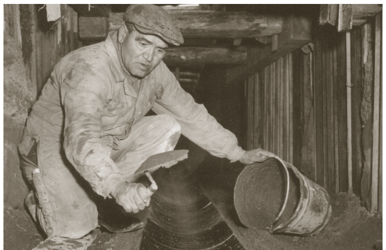
Kanalmaurer bei der Herstellung der Sohlauskleidung 1951
