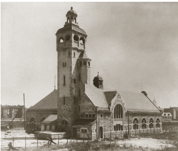
Das Pumpwerk Ochsenpferch 1904
