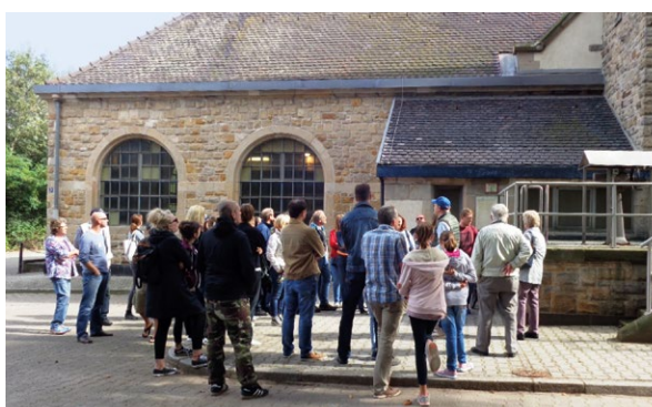
Führung im Pumpwerk Ochsenperch am Tag des offenen Denkmals
