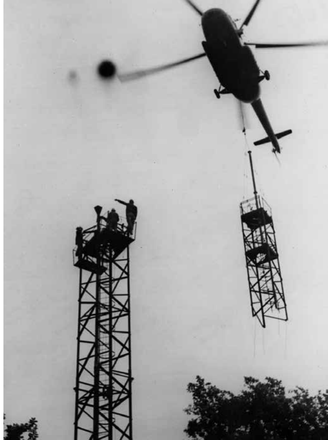
Die Deutsche Post der DDR montiert 1986 an einer Funkstelle bei Friedrichroda mithilfe eines Hubschraubers einen UKW-Sendemast
