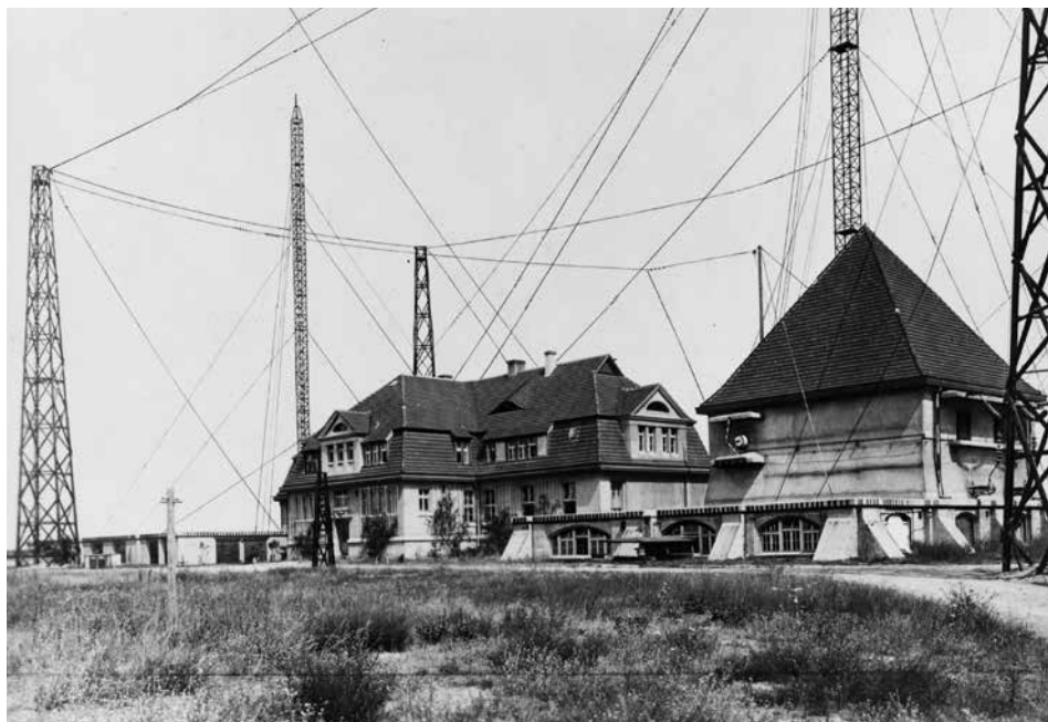
Auf dem Windmühlenberg bei Königs Wusterhausen, dem späteren Funkerberg, wurde im Jahre 1914 von der Militärverwaltung eine Funkstation aufgebaut, die am 15. Juni 1916 in Betrieb ging. Nach dem 1. Weltkrieg übernahm die Deutsche Reichspost die Funkstation, die unter Hans Bredow für den Wirtschaftsfunk auf Röhrensender umgerüstet und mit zwei weiteren Antennenmasten ausgestattet wurde
