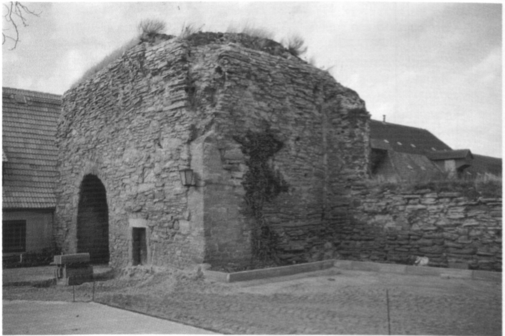
b Westliches Querhaus mit Anschluß Langhaus, Ansicht von Südosten
