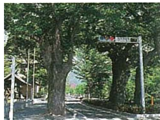
アスファルト厚増による基盤確保 「新・緑の仕事」 ／東邦シオ株式会社
