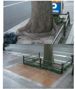
車道の路盤（根の伸長不可部） 根の伸長できる硬度で、透水・通気性のある路盤 出典：街路樹／山本紀久著
