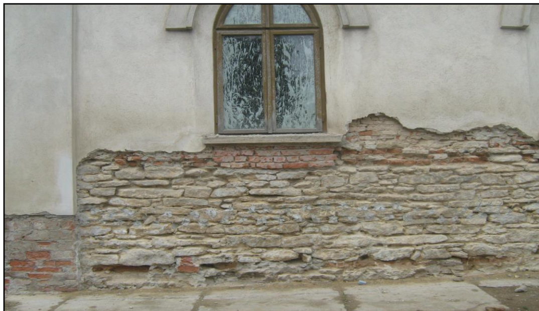
Decapare tencuială până la cărămidă
