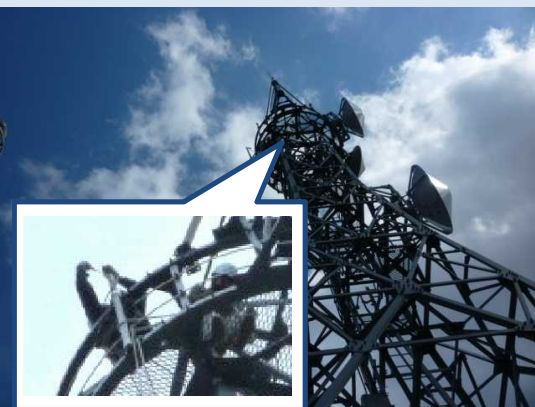
余震が続く中、高所での応急措置作業
