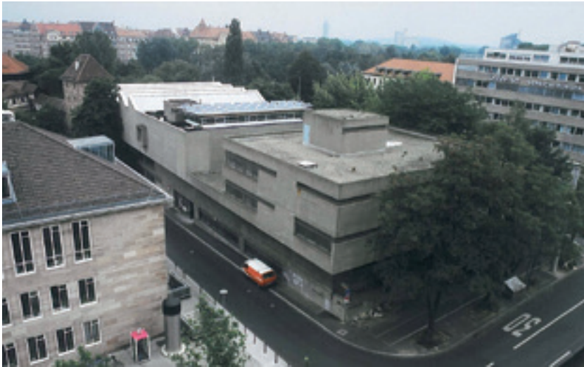
Die Norishalle von Südwesten. (Stadt Nürnberg, Hochbauamt)
