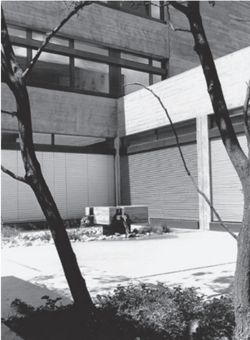
Blick in den Innenhof. Foto Hochbauamt 15.5.1969. (StadtAN A 40 L 872-27a)
