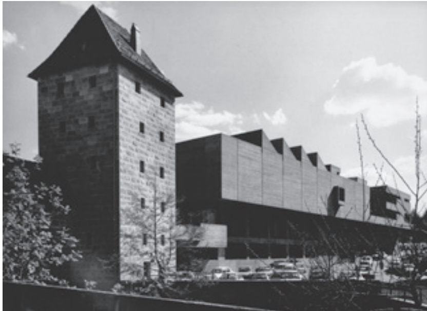
Die Norishalle von Nordosten mit dem Turm Blau B. Das aus der Nordwestfassade hervor kragende Fenster gibt einen sehenswerten Blick auf Altstadt und Burg frei, Foto April 1972. (StadtAN A 40 L 1312-66)
