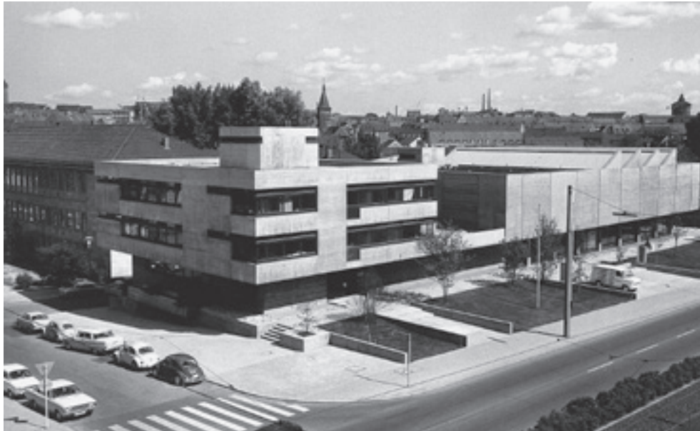
Die Norishalle kurz nach Fertigstellung, Foto 1969. (StadtAN A 40 L 872-7a)
