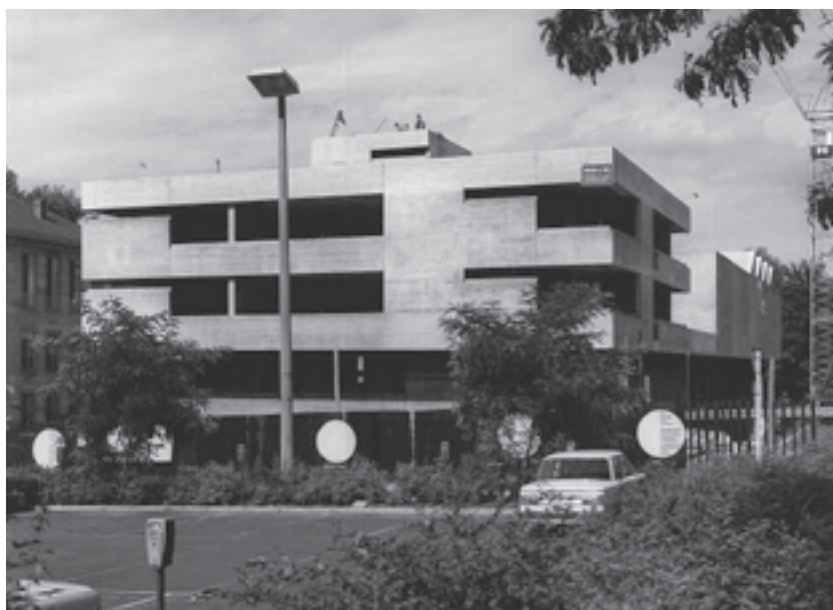
Der Bürotrakt im Bau, Foto 21.8.1967. (StadtAN A 39 Fi 11 1668)
