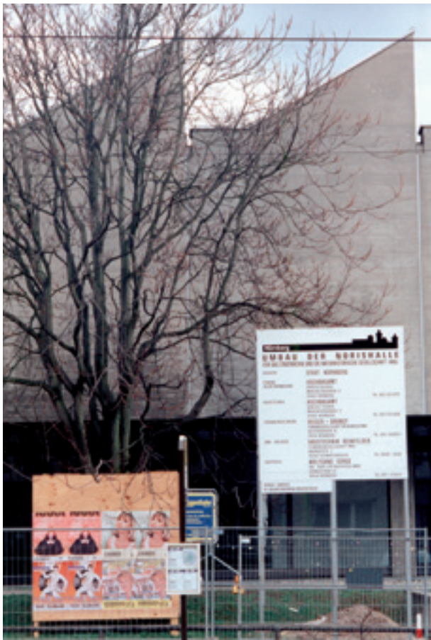
Bautafel vor der Norishalle, Foto März 1998. (Stadt Nürnberg, Hochbauamt)
