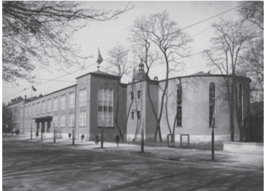
Mit dem Umbau erhielt die Norishalle eine gemäßigt moderne Außenhülle. Der halbrunde Anbau wirkt mit seinen hohen schmalen Fenstern wie eine Kirchenapsis. Foto 1928. (StadtAN A 64/I-134)
