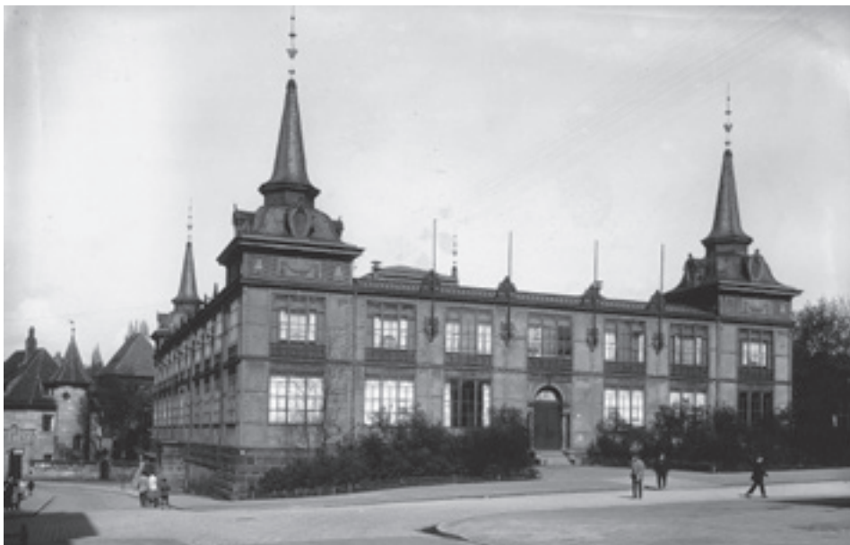
Die Südfassade kurz vor dem Umbau 1927. Der marode Zustand machte einen kompletten Umbau notwendig. Die auf den Fotografien aus den 1890er Jahren noch deutlich zu sehenden ornamentalen Malereien auf den Mauerfeldern sind fast völlig verschwunden, Foto 4.5.1927. (StadtAN A 38 II Repro)
