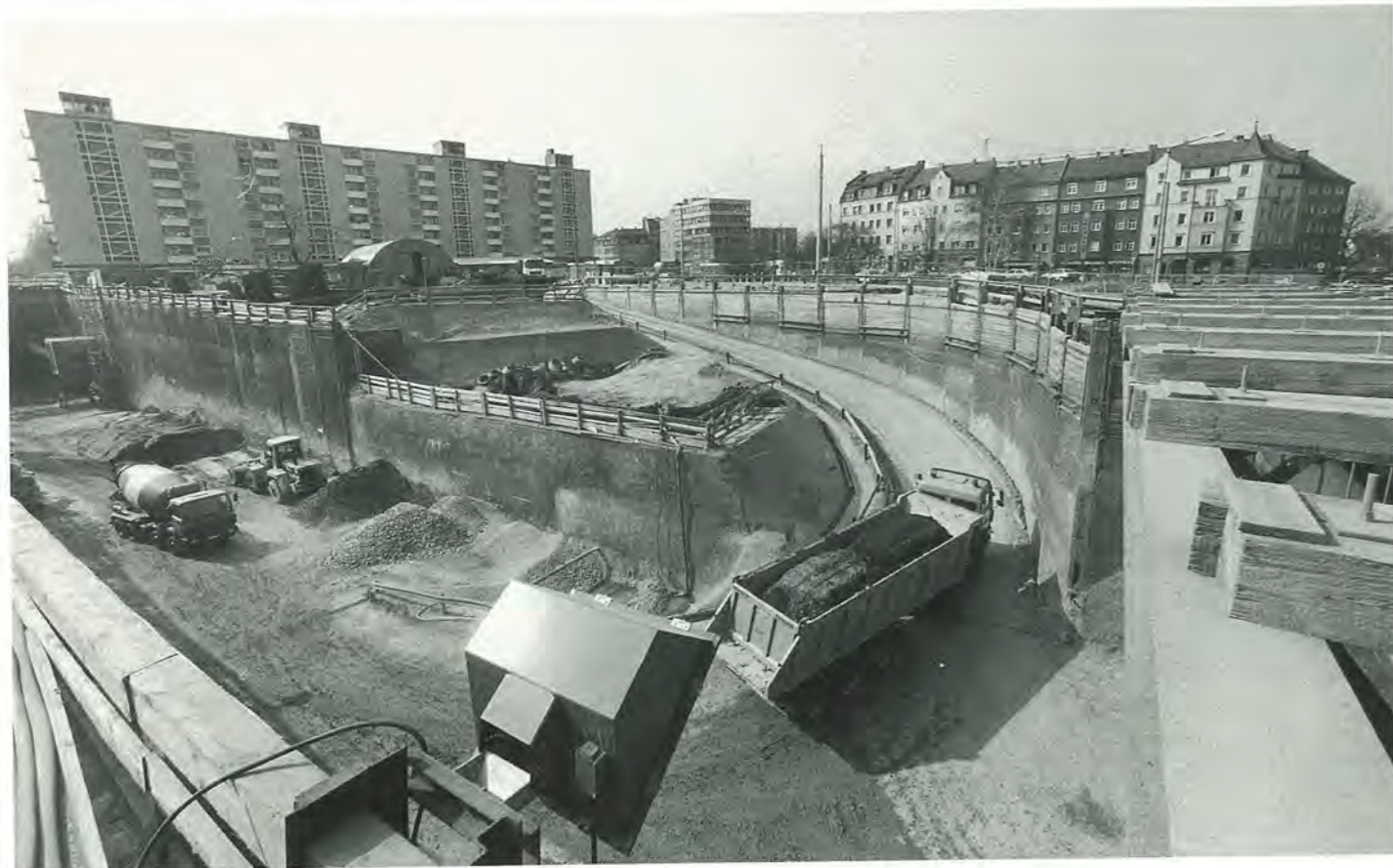
Leipziger Platz: Die Baugrube für den U-Bahnhof dient den zwei Tunnelvortriebsmaschinen als Basis für den Bau der Tunnelröhre in Richtung Schoppershof und für beide Röhren in Richtung Norden zur Herrnhütte.
