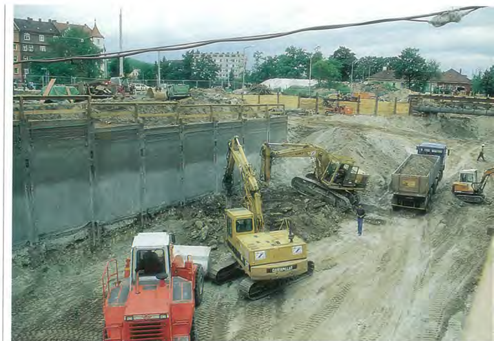
Aushub der Baugrube am Leipziger Platz für den U-Bahnhof Nordostbahnhof.
