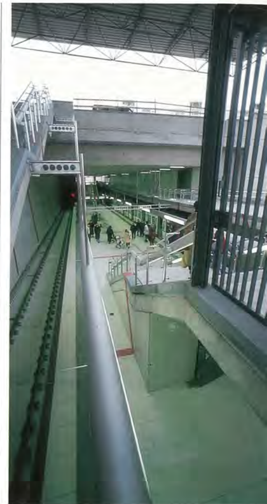
Rote Streifen gliedern die Wände der U-Bahnstation Nordostbahnhof. Im Bild der Blick vom Zwischengeschoss auf den Bahnsteig.
