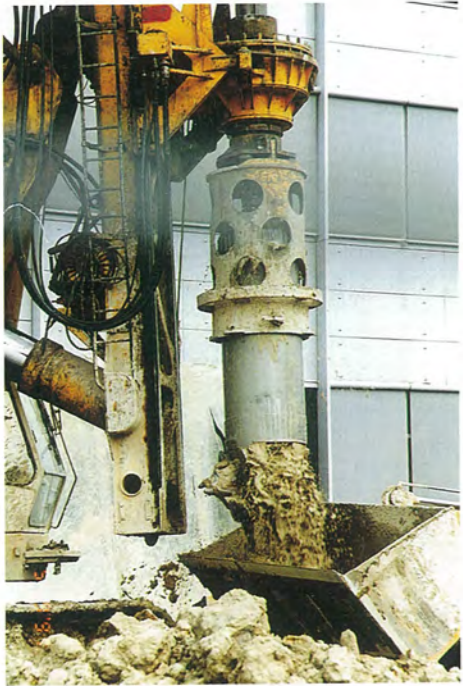
Bohrgerät beim Trägerbohren (oben links).
