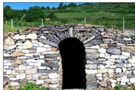
gewölbter Kellerabgang Foto: Mag. R. Vogler
