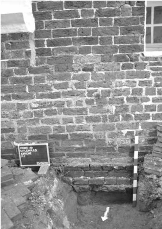
Erdarbeiten an der Nordseite der Kirche von Upleward boten einen Einblick in den Fundamentaufbau (Foto: Ines Reese, Ostfriesische Landschaft).
