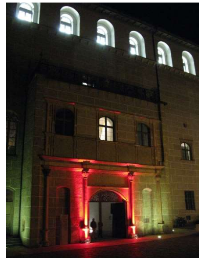
Foto vom Verfasser Abb. 26: Schlosseingang
