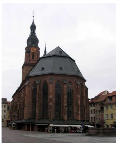
Foto vom Verfasser Abb. 79: Heidelberg: Die Hl. Geistkirche
