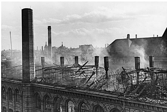
Das Firmengebäude nach den Bombenangriffen 1943
