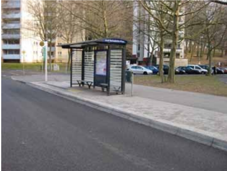
Abbildung 28: Beispiel für die Ausbildung einer Haltestelle als Buskap, Bordsteinausbildung mit „Kasseler Bord“, taktiles Leitsystem mit Aufmerksamkeitsfeld (gelb) an der 2. Bustür (Beispiel: Kassel)
