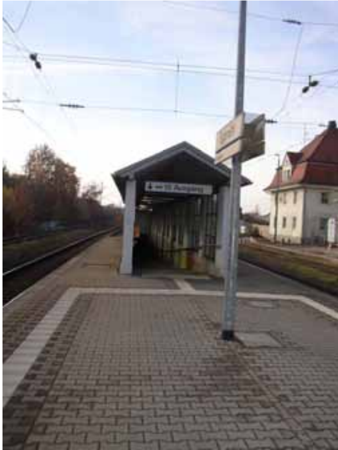
Abbildung 12: Barrierefreier Zugang zu den Bahnsteigen am Bahnhof Eggmühl
