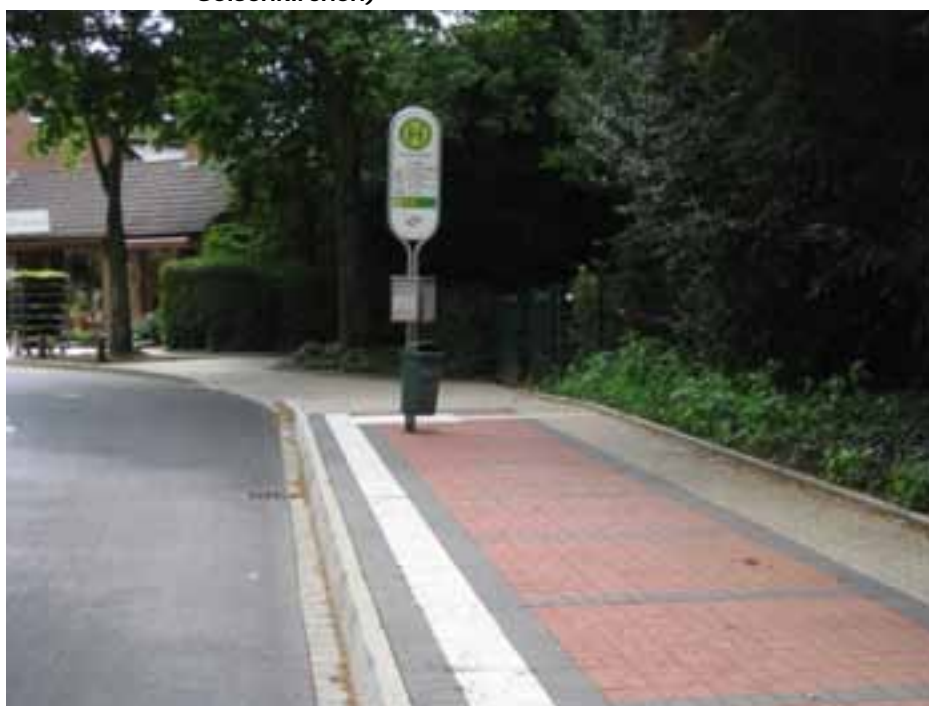
Abbildung 29: Haltestelle mit taktilem Leitsystem Haltestelle mit Auffangstreifen in Höhe des Haltestellenschildes (Höhe 1. Bustür); Bordsteinausbildung mit Buskapstein (Beispiel: Gelsenkirchen)
