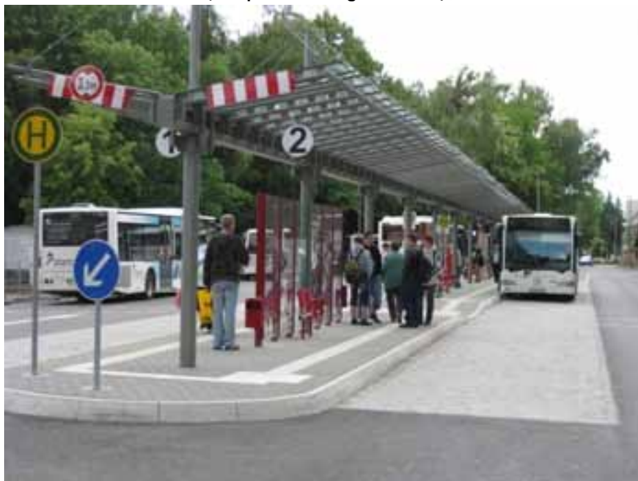
Abbildung 30: Vollständiges taktiles Leitsystem und niederflurgerechte Borde an einer Haltestelleninsel (Beispiel: Freiberg/ Sachsen);
