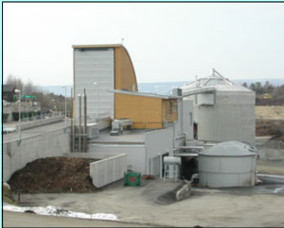
Figur 14.2 Biogassanlegget på GLØR (Gausdal-Lillehammer-Øyer Renovasjon)
