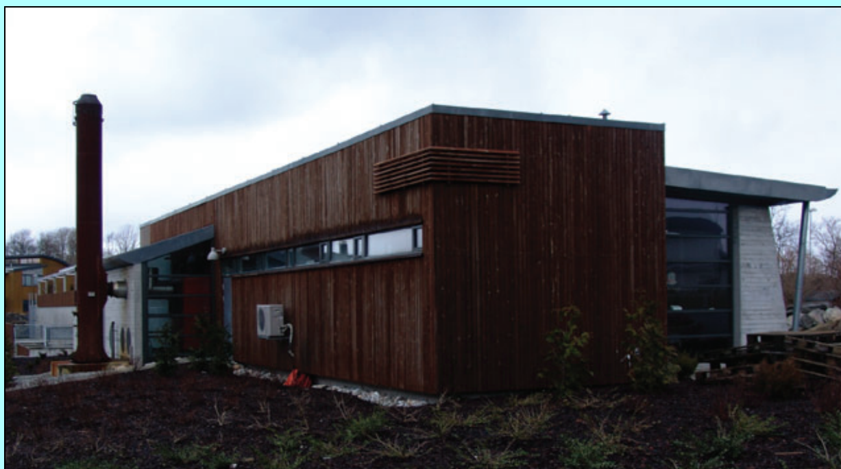
Figur 17.2 Fjernvarmesentral fra Stavanger kommune. Første fjernvarmesentral (1998) med varmpumpe basert på sjøvarme på Hundvåg i Stavanger. Varmesentralen betjener 220 boliger med oppvarming og varmtvann. Tilført elektrisk energi til boligene er redusert med 50 prosent i forhold til normalt nivå.
