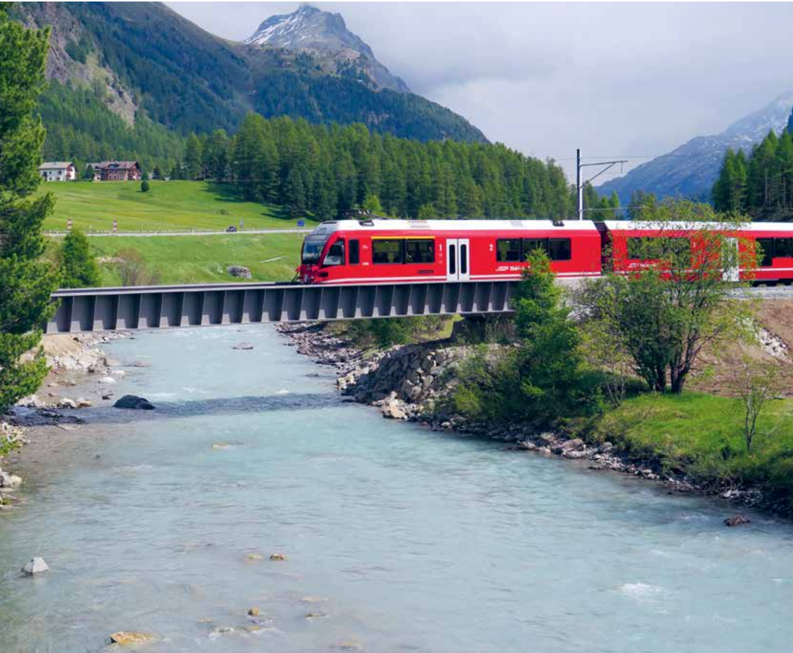
Neue Flazbachbrücke bei Punt Muragl
