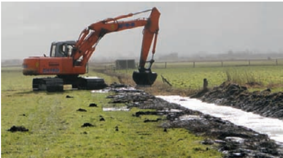
Abb.2: Baggerarbeiten im Februar 2011 im Meggerkoog (Foto Heike Jeromin)
