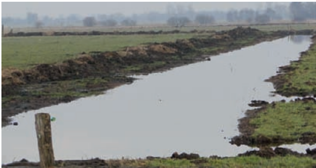
Abb. 3: Gestauter und auf- geweiteter Graben im Meggerkoog Fe- bruar 2011 Foto Heike Jeromin)
