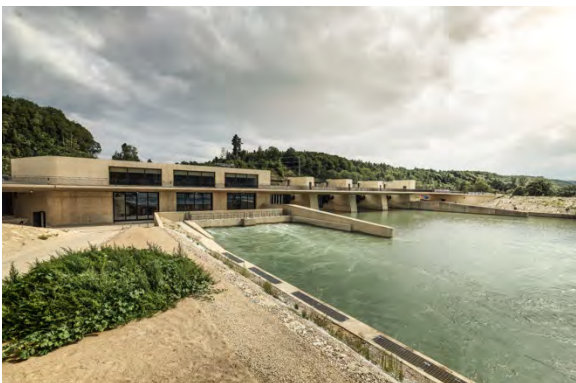
Flusskraftwerk Hagneck (BKW)
