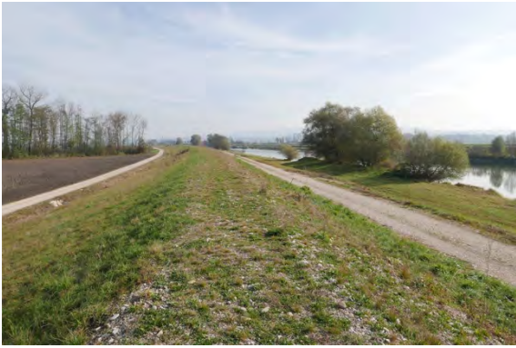
Neuer Damm am Hagneckkanal
