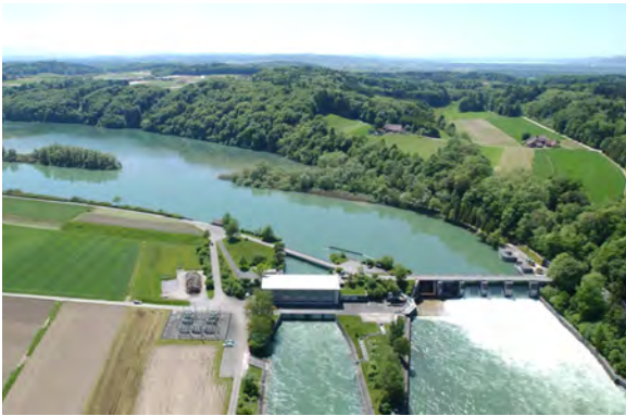
Flusskraftwerk Niderried-Radelfingen (BKW)
