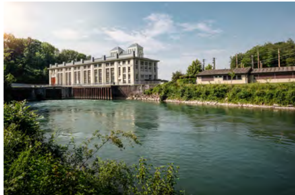
Flusskraftwerk Kallnach (BKW)
