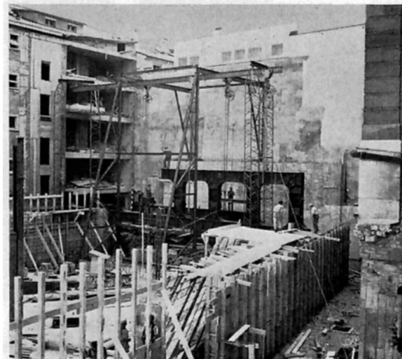
Fig. 6: Vue générale du chantier
