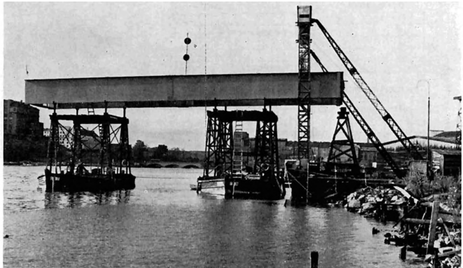
Bild 7: Hauptträger-Paar nach der Verladung auf Prahmen am Werkstätten-Kai
