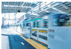
ホームドア、 センサー付固定式ホーム柵 整備率 100%
