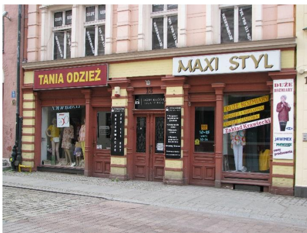
Elewacja z chaotycznymi reklamami [ul. Wielkie Garbary 13]
