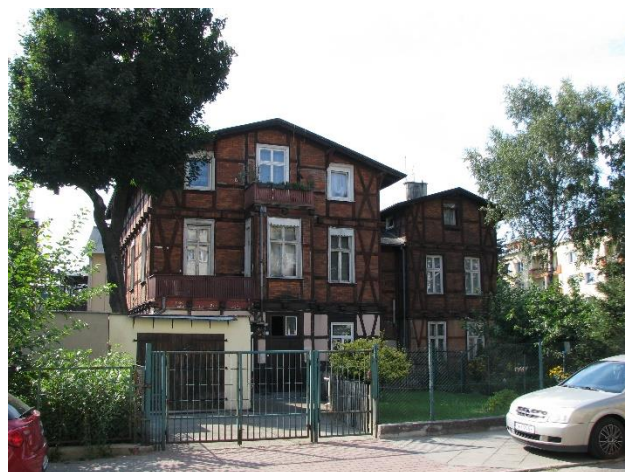
Budynek szkieletowy z współczesnym garażem [ul. Bydgoska 24]
