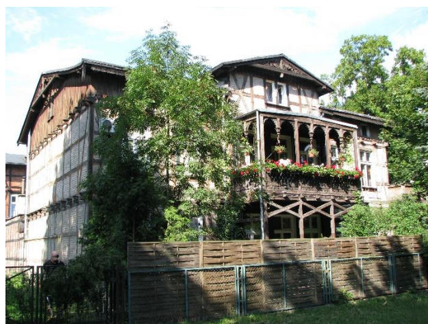
Budynek szkieletowy z gankiem, zachowane elementy snyczerki [ul. Bydgoska 32]
