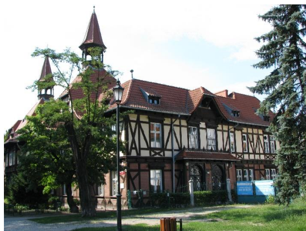
Budynek Przedszkola i Społecznego Ogniska Artystycznego [ul. Bydgoska 34–36]
